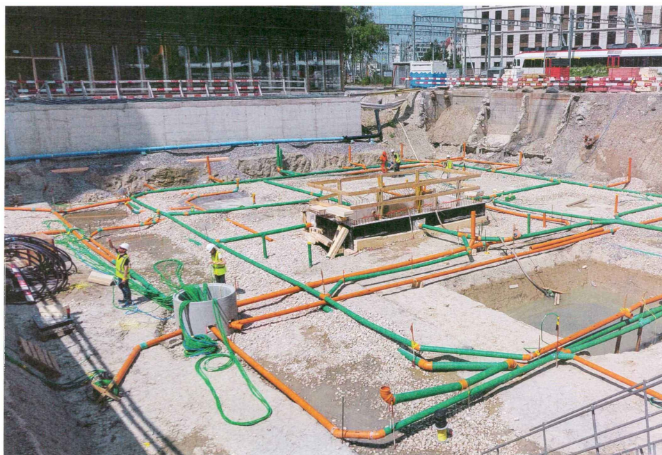
Mise en place sur le chantier de l'infrastructure de monitoring du radon et autres gaz du terrain (BUILDING2050 [EPFL | SMART LIVING LAB], 2025)
