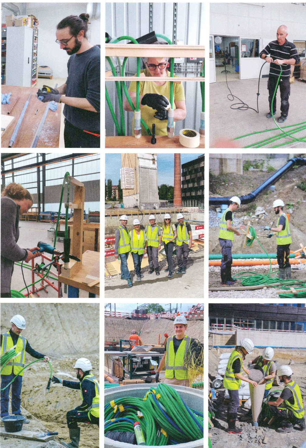
Expérimentation d'une démarche Living Lab à l'occasion de la conception puis de la production et de la mise en place de la centaine de sondes prévues pour le monitoring du radon sur le chantier du futur bâtiment du Smart Living Lab à Fribourg. Coordination de l'intégration dans le bâtiment et interfaces chantier-recherche: groupe Building2050, EPFL. (PHOTOS: BUILDING2050 [EPFL | SMART LIVING LAB], 2025 ET CROQAIR TRANSFORM HEIA-FR | SMART LIVING LAB, 2025)
