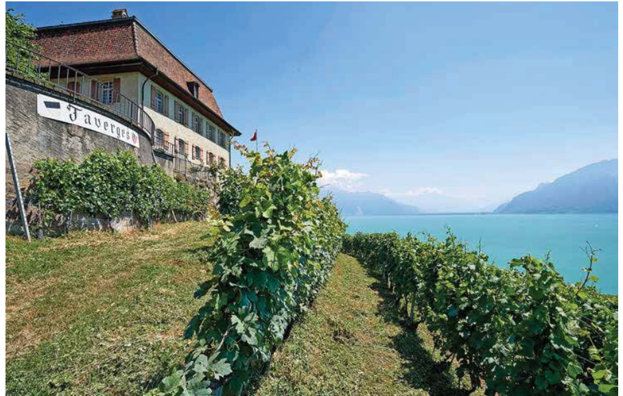
Die Gebäude des Weinguts des Kantons Freiburg in Faverges werden renoviert.
