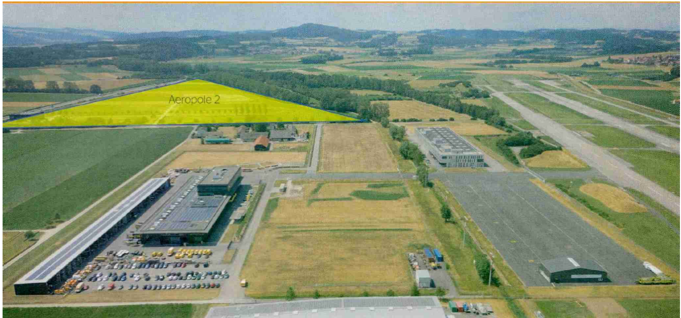
Site de la zone Aeropole 2 du parc technologique Swiss Aeropole, à Payerne.
