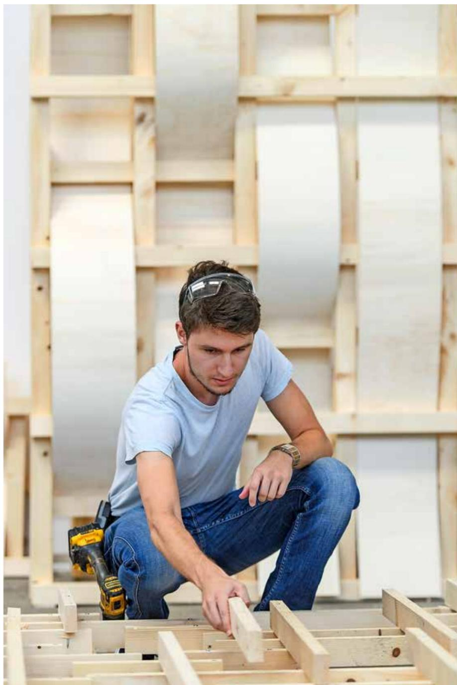
Avant d'installer leurs panneaux d'absorption du son à Fri Art, les étudiants en architecture ont scié et assemblé bois et bouteilles en PET dans une halle de Bluefactory. Alain Wicht
