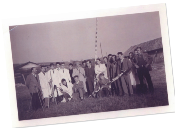
▲ Une classe de l'École des chefs de chantier, 1957
