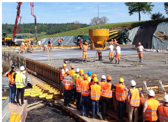
▲ Visite de chantier
