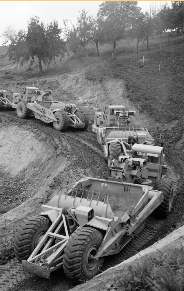
◀ Construction du barrage de Schiffenen : Kleingurmels, colonne de scrap dozer en action (27.09.1960)
