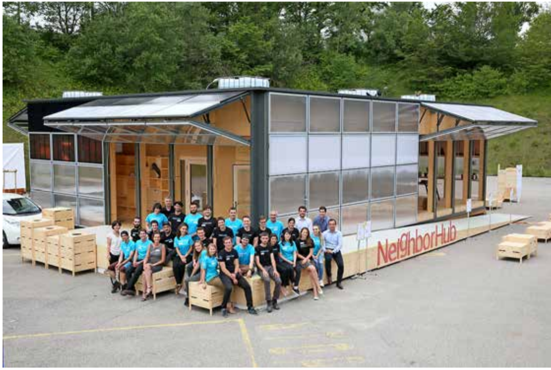
Das in der Blue Factory aufgebaute Solarhaus «NeighborHub» vor dem Transport nach Denver.
