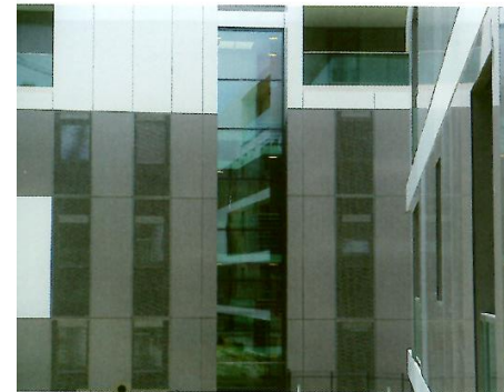
L'aération des bâtiments neufs est d'autant plus importante que l'isolation est de plus en plus performante. Laszlo Mavilia
