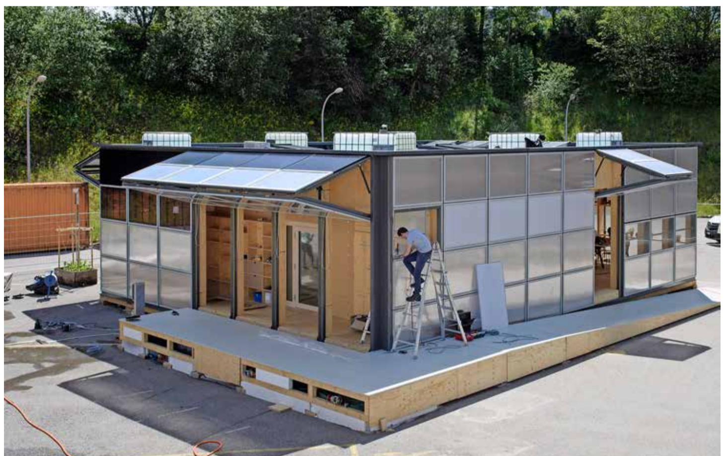
Der «Neighbor Hub» wird energetisch ausschliesslich mit Solarenergie versorgt.
