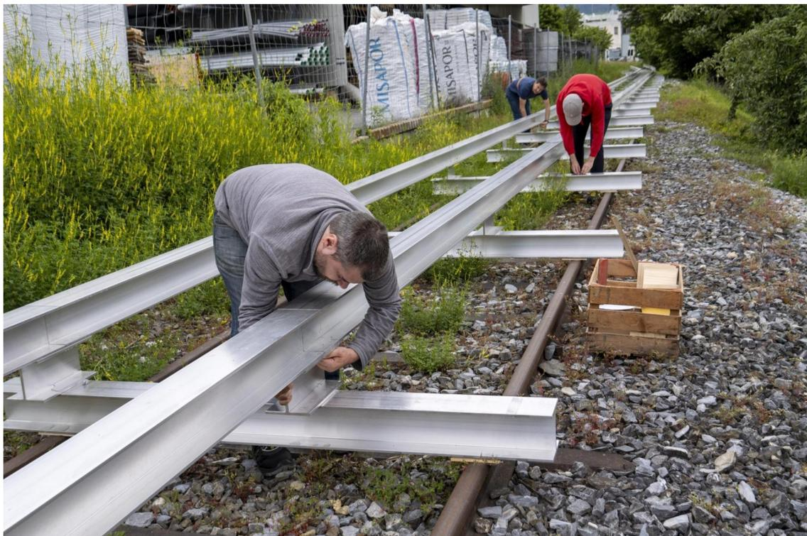
A Sion, cette nouvelle infrastructure ferroviaire permet à des véhicules à sustentation magnétique d'y circuler jusqu'à une vitesse de 130 km/h.
