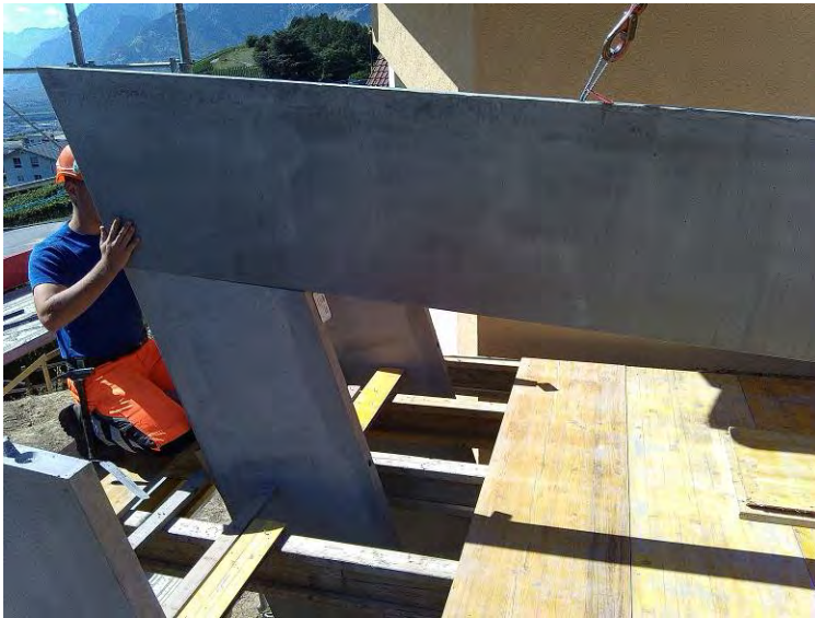
Fig. 6 Mise en place du sommier par emboîtement dans le poteau
