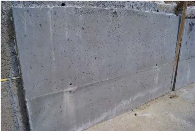
Fig. 12 : Essai de bétonnage ép. 8cm
