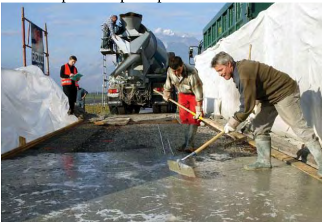
Fig. 1 Pont sur la Morge (A. Herzog)[1]
