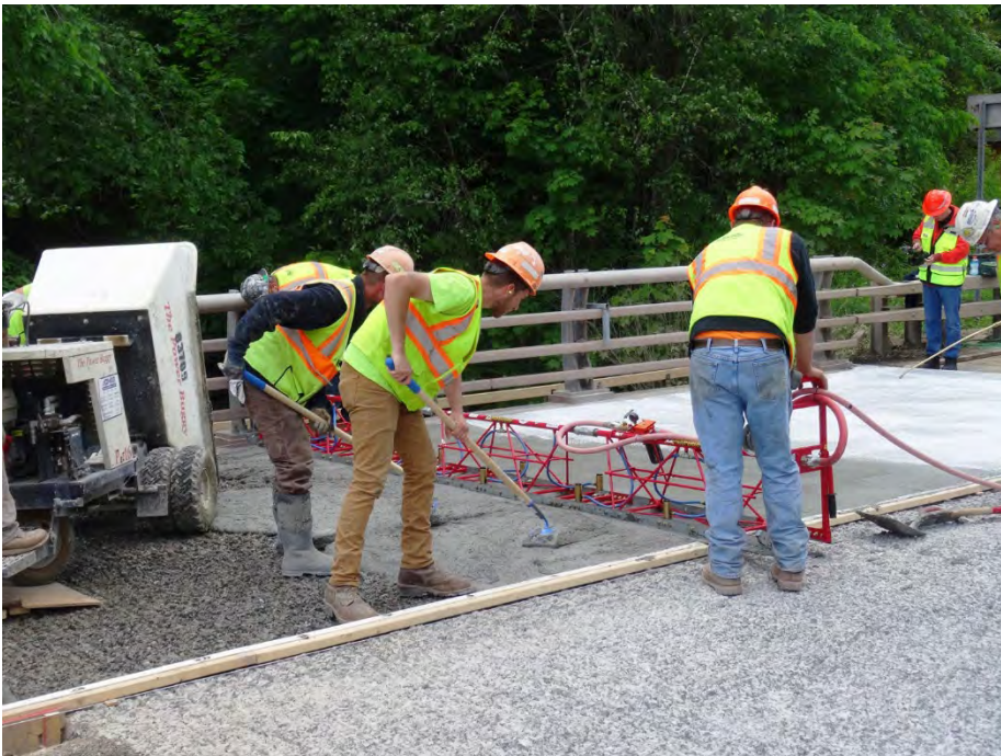
Fig. 5: Einbau von UHFB der Sorte UA (Schichtstärke 1 ½ inch) auf Strassenbrücke über den Joe Brook River in Hortonville, Bundesstaat New York, 4. Juni 2019, Foto: E. Brühwiler.
