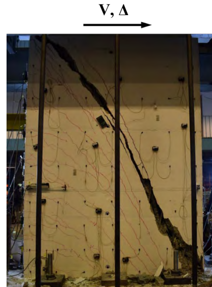
Fig. 10 : Rupture du voile 1
