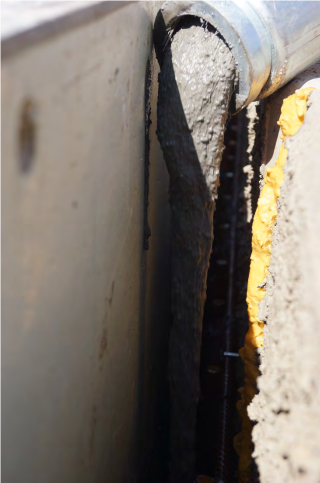
Fig. 19 : Sortie de la buse du BFUP pompé
