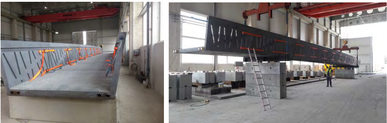
Fig. 8 : Assemblage de la passerelle en usine
