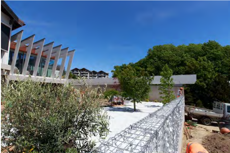
Fig. 12 Vue d'ensemble du projet
