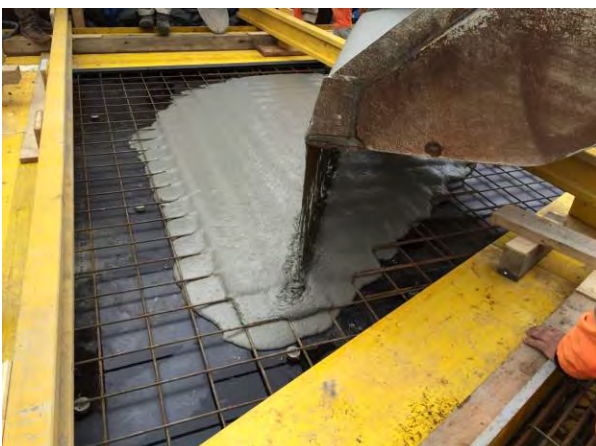
Fig. 5 Coulage à partir de la benne dans le coffrage.
