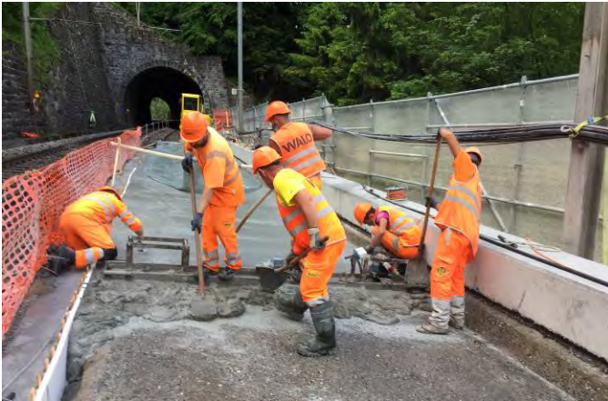
Fig. 4 Pose du BFUP – pente transversale 10%
