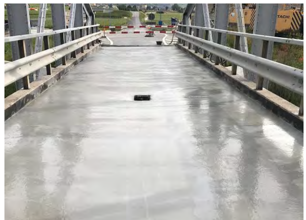
Fig. 9 Surface du BFUP finie
