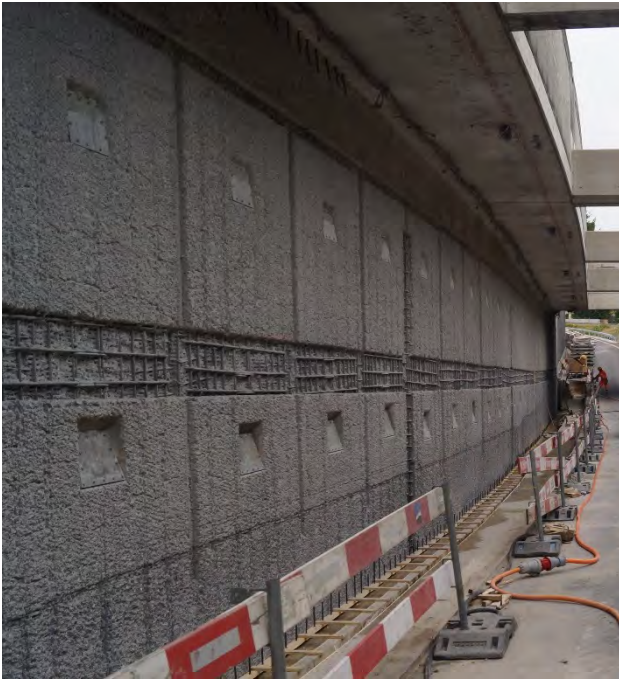
Fig. 23: Paroi après hydrodémolition
