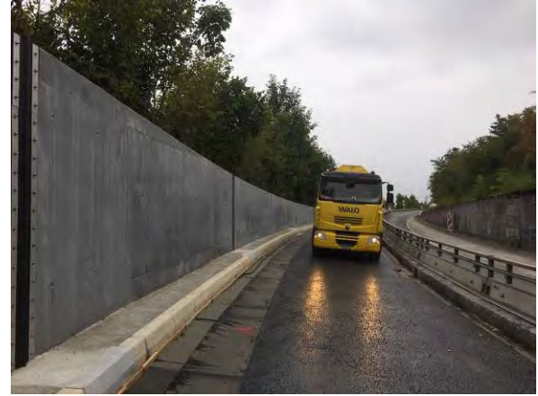
Fig. 11 Surface du BFUP finie
