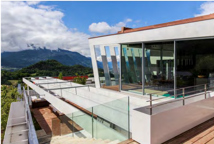
Fig. 1 Vue d'ensemble du projet
