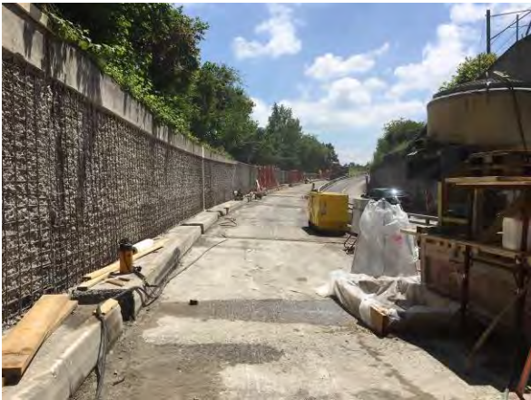
Fig. 10 Assainissement du mur de soutènement
