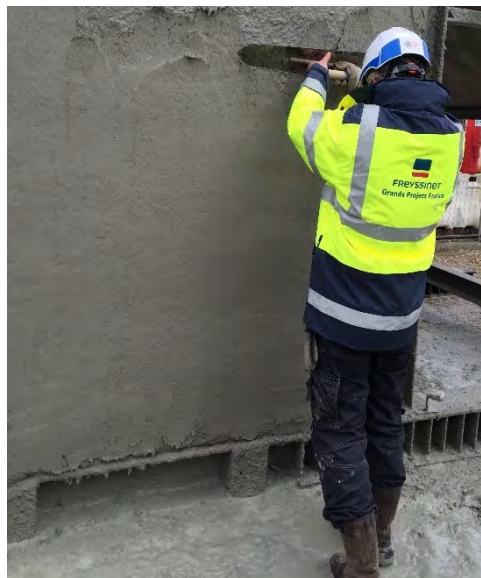
Figure 7 : Essais de convenance : état de surface après la projection
