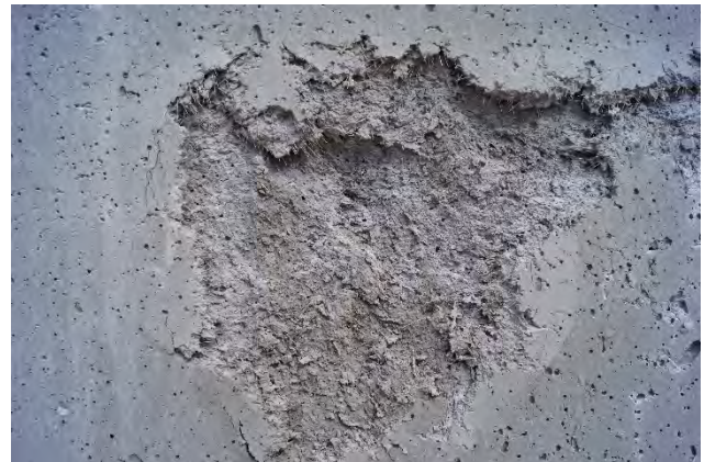
Fig. 15 : Zoom sur l'arrachement
