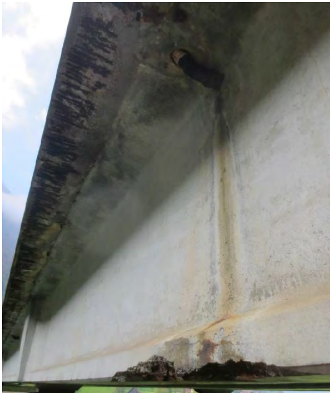
Abbildung 3: Betonabplatzungen
