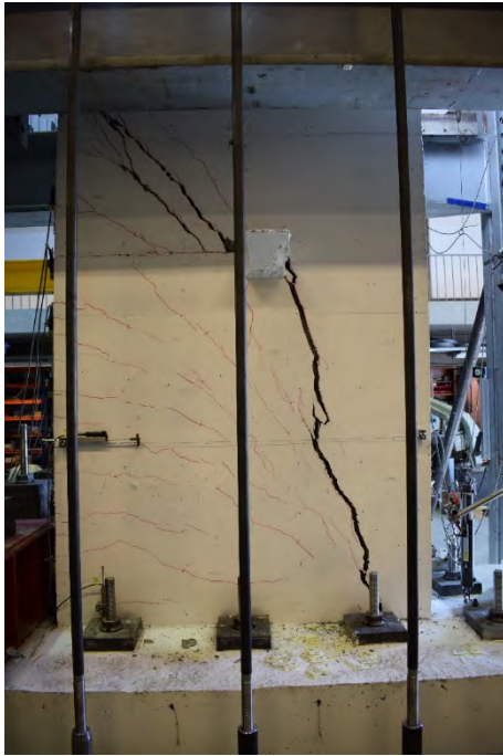
Fig. 12 : Rupture du voile 2
