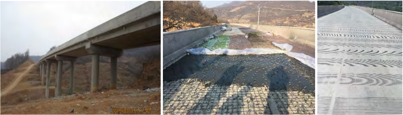
Fig. 3: Abdichtung und Verstärkung der Fahrbahnplatte der Miaozi Brücke in China, 2016, (Fotos: Lan Duan, Chang'An University Xian).
