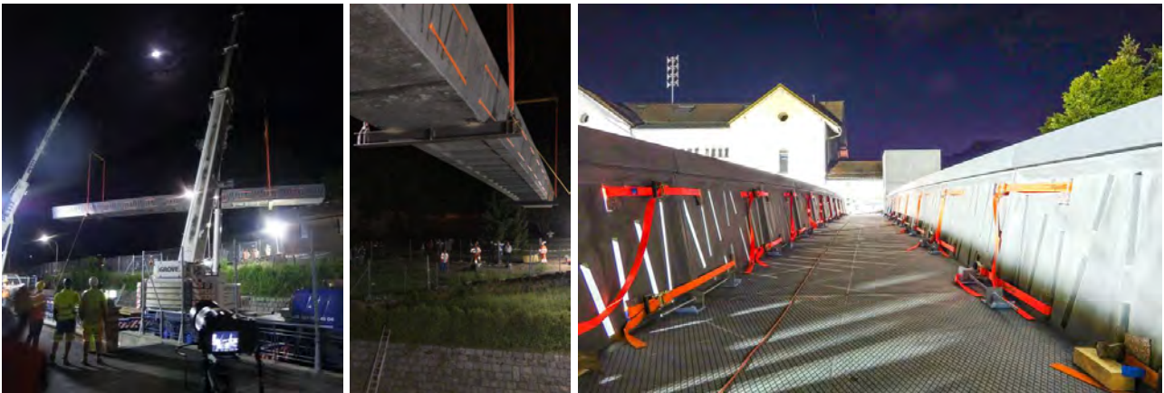
Fig. 9 : Montage de la passerelle au Bouveret
