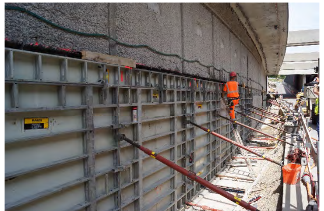
Fig. 26: Coffrage d'une étape
