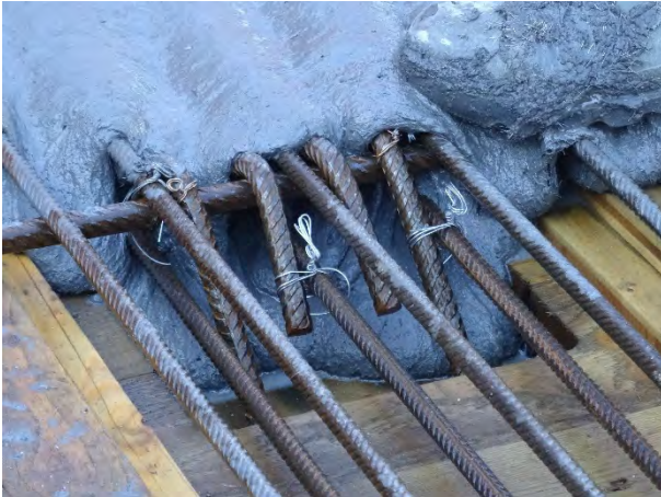
Fig. 4: Schubverbinder mit Bewehrung
