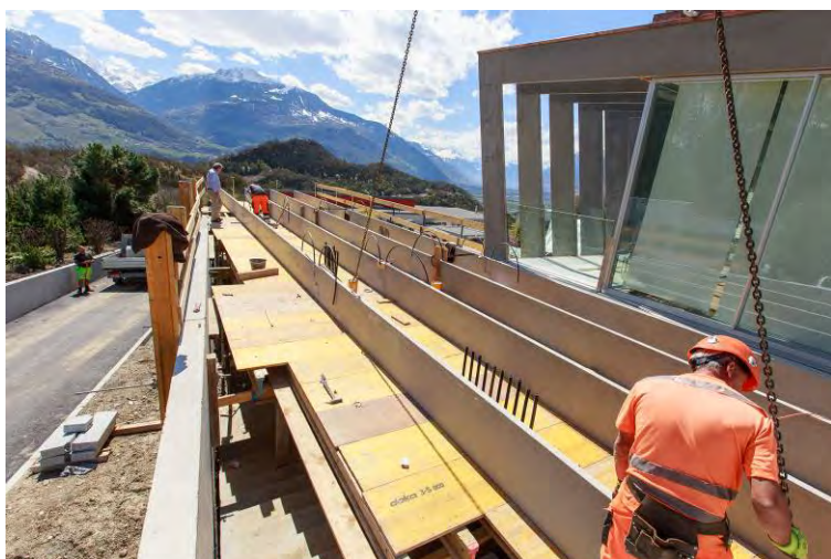
Fig. 11 Vue d'ensemble de la pose des lames - pergola
