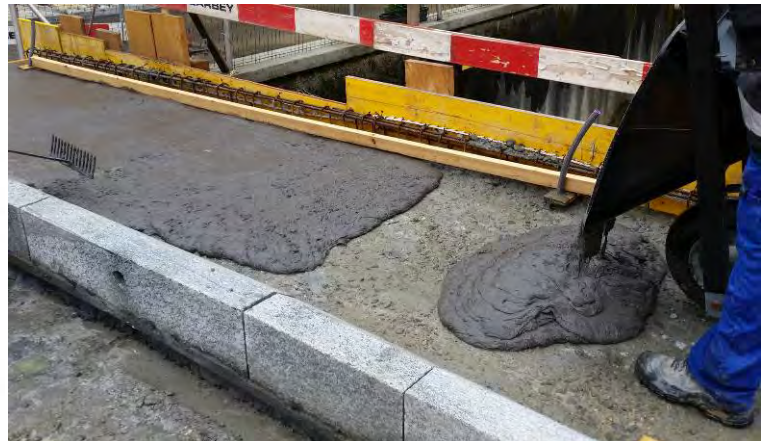
Fig. 18 Mise en place de BFUP à la main
