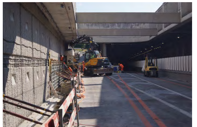
Fig. 28: Bétonnage de la 2 ème étape
