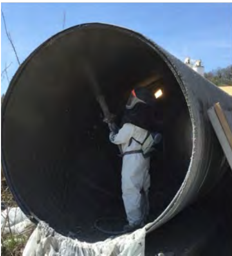
Figure 6 : Essais de convenance : pendant la projection
