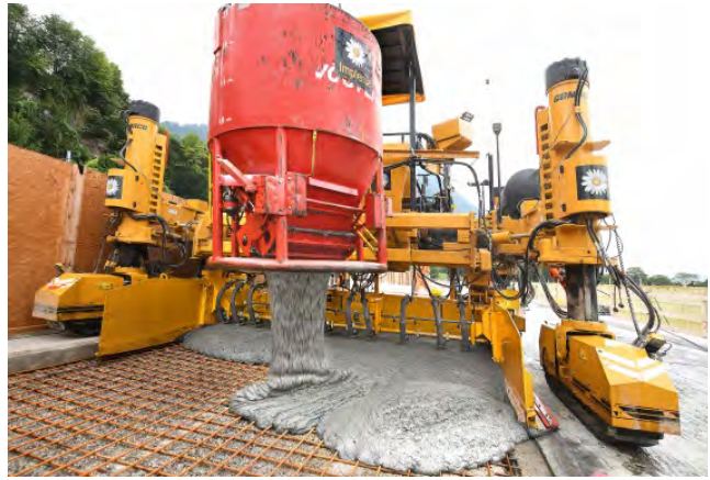
Abbildung 16: Verteilen Frisch-UHFB mit Betonkübel
