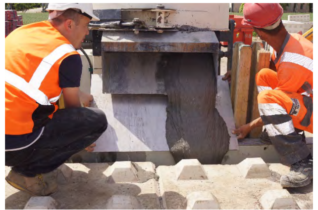
Fig. 21 : Déversement direct du BFUP
