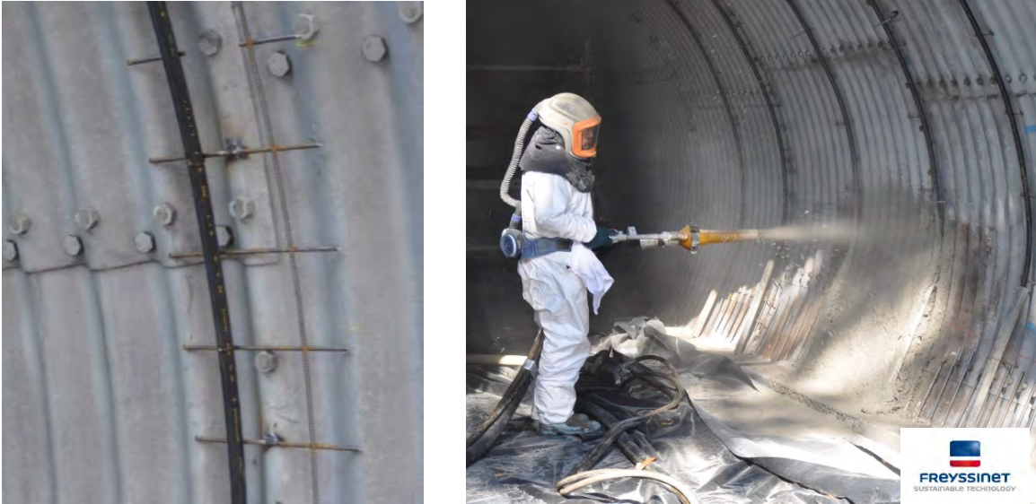
Figure 8 : Ferrailage de reprise et gabarits d'épaisseur
