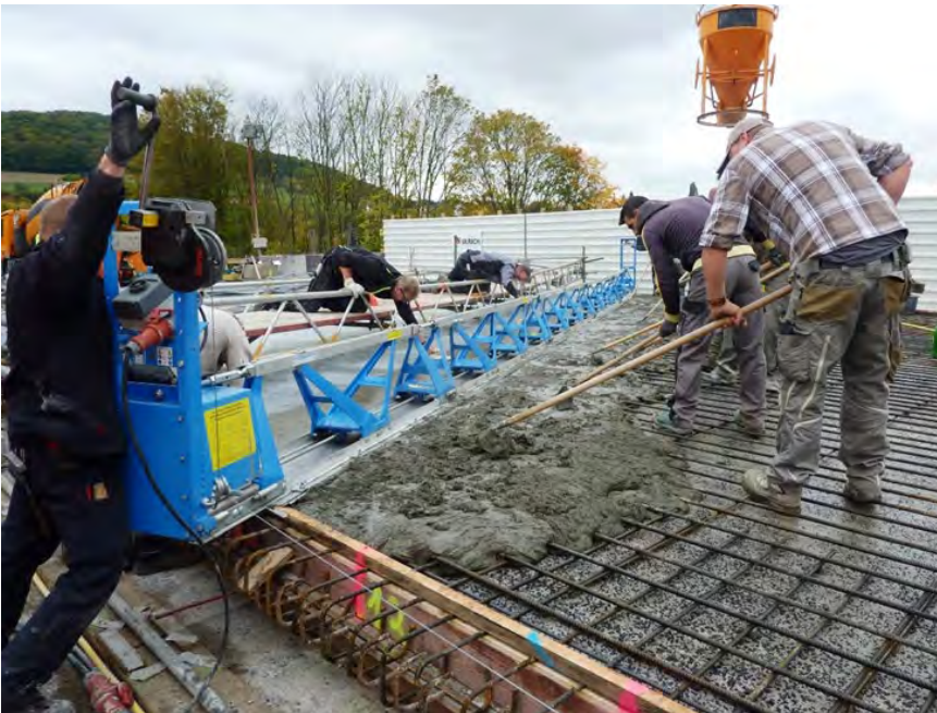
Fig. 4: UHFB-Einbau auf der Fahrbahnplatte für den Ersatzneubau einer Strassenüberführung über die Bundesstrasse B27 bei Fulda, Deutschland, 11. Oktober 2017, Foto: E. Pelke.
