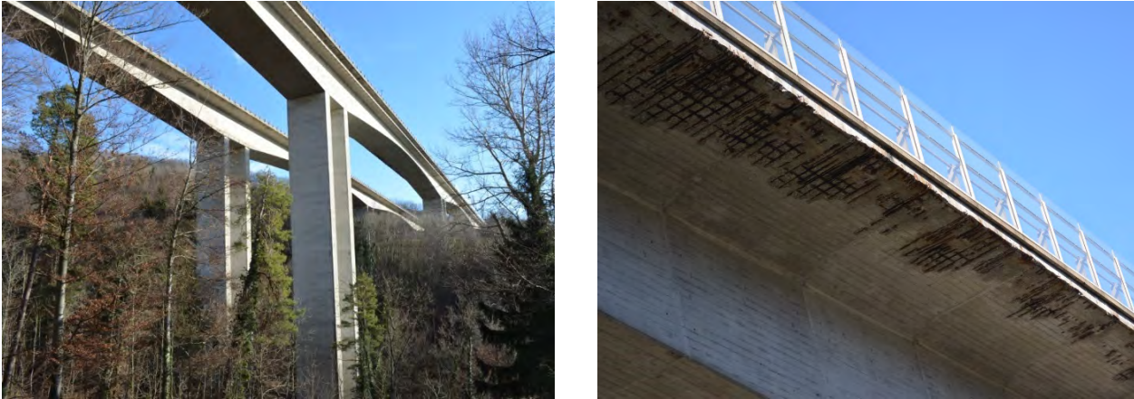
Fig. 1 : Vues des ponts sur la Paudèze avant l'intervention
