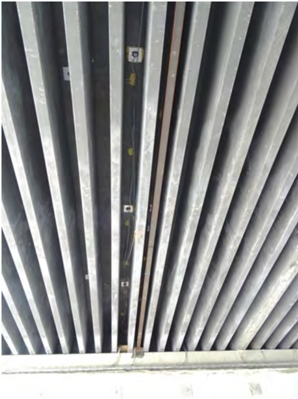
Bild 9: Ansicht der UHFB-Rippenplatte mit Sensoren und eingelegtem Referenzbalken für die Durchbiegungsmessung.
