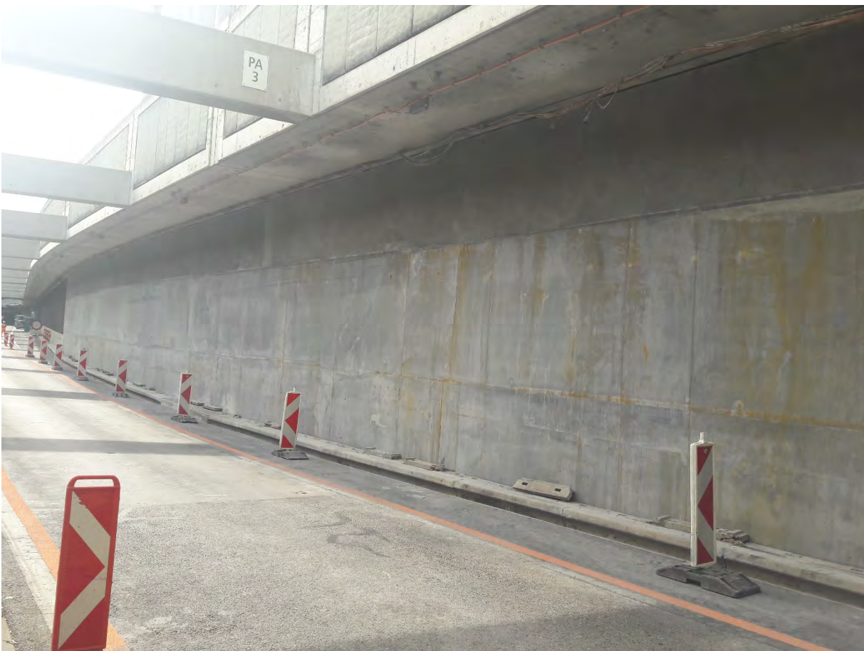
Fig. 30: Vue de la paroi après travaux
