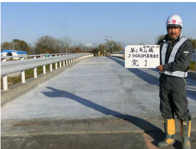
Fig. 2: Abdichtung und Verstärkung der Fahrbahnplatte einer Strassenbrücke in Sapporo mit dem UHFB J-THIFCOM, Oktober 2014 (Foto: Y. Kosaka).
