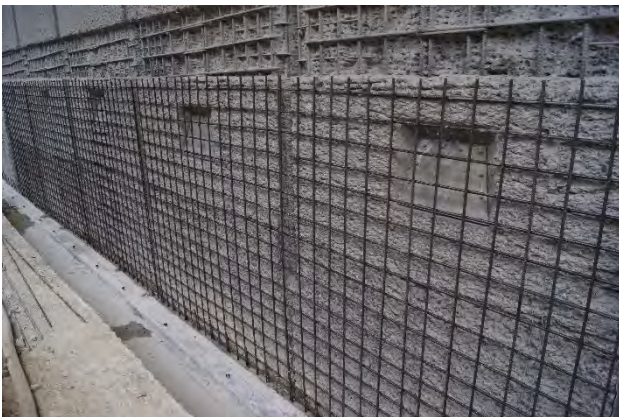
Fig. 25: Ferrailage d'une étape
