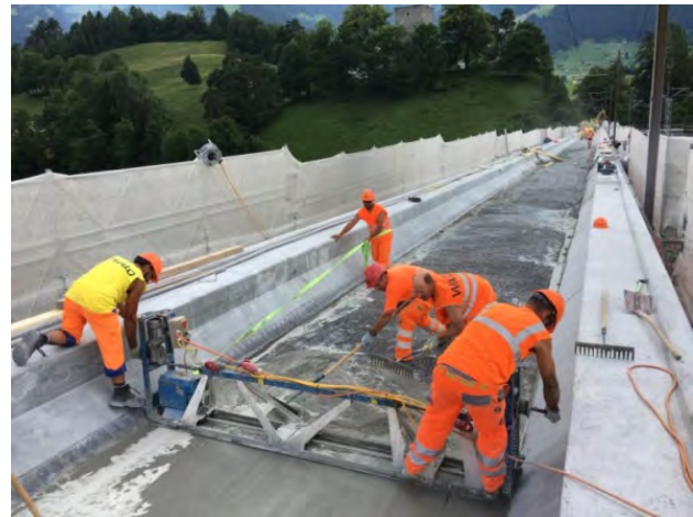
Fig. 10: Flächiger Einbau des UHFB
