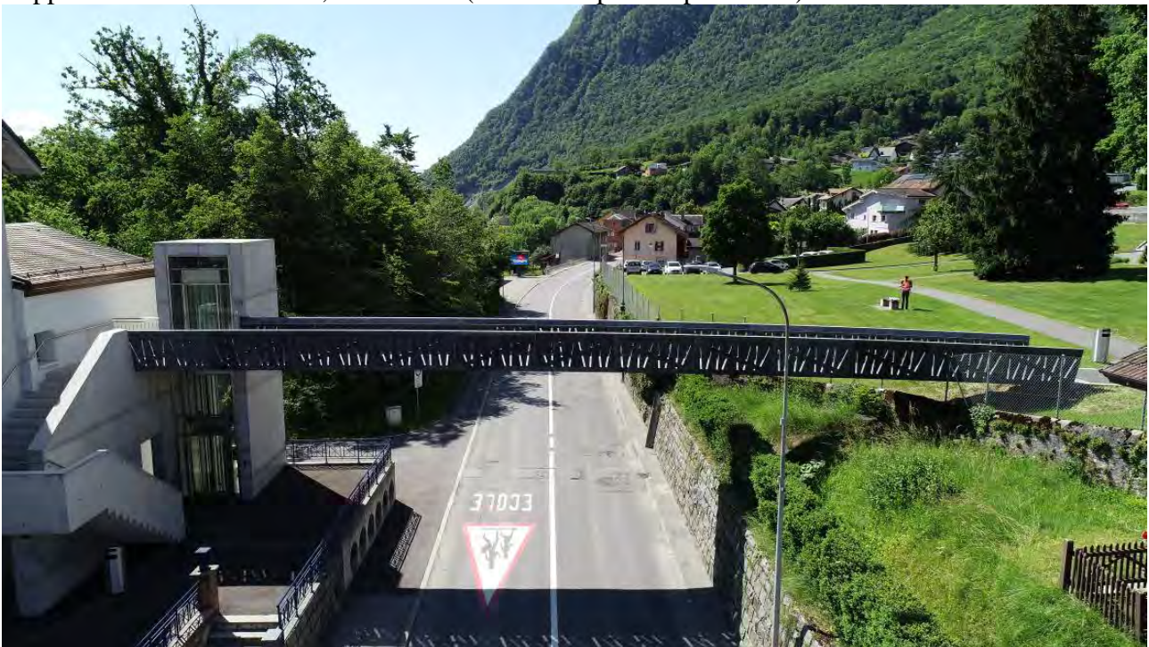
Fig. 10 : Vue de la passerelle
