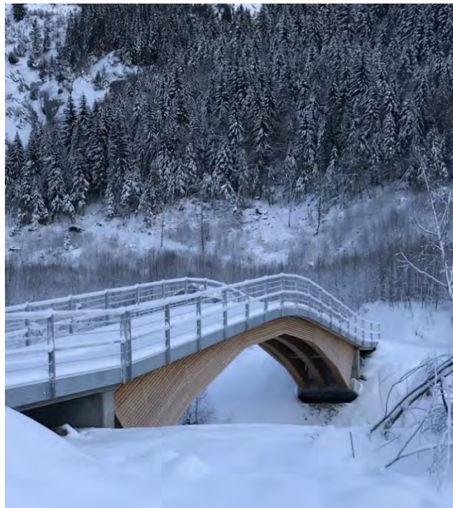
Fig. 1: Gletschersandbrücke nach Fertigstellung
