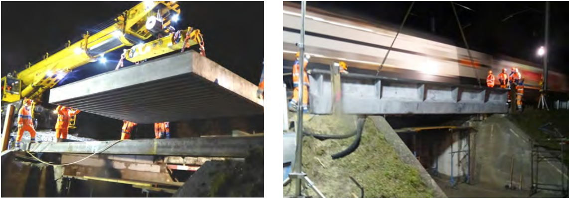
Bild 7 und 8: Versetzen der vorfabrizierten UHFB-Rippenplatte und des Randträgers auf die Widerlager (bei Zugsdurchfahrt auf dem benachbarten Gleis).
