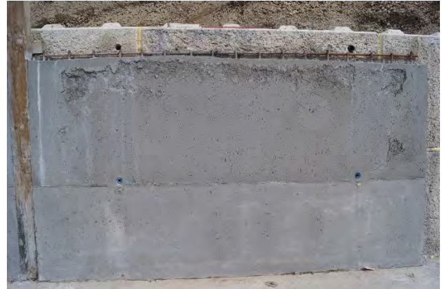
Fig. 13 : Essai de bétonnage ép. 10cm
