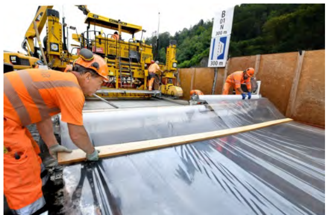
Abbildung 17: Abdecken UHFB mit Folien
