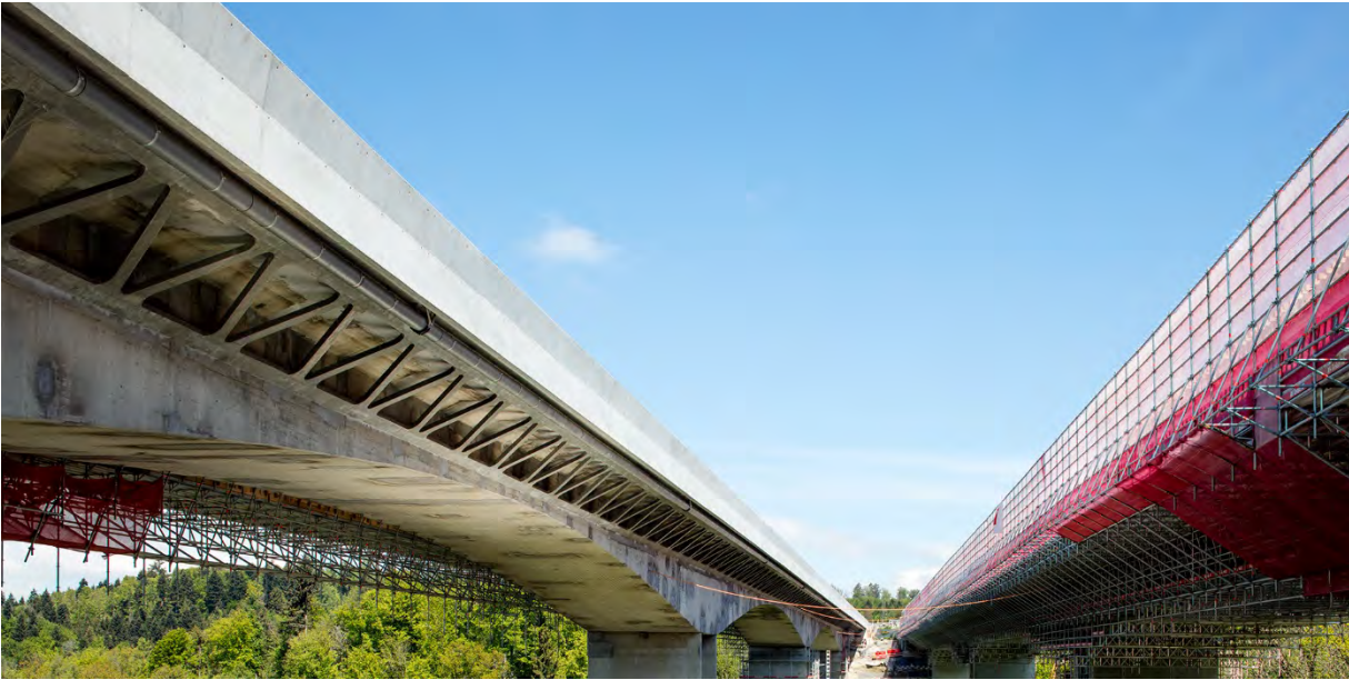
Fig. 12 : Vue d'ensemble à la fin des travaux 2018
