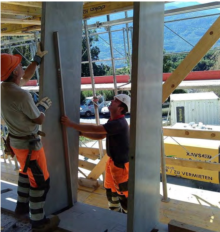
Fig. 4 Mise en place des poteaux
