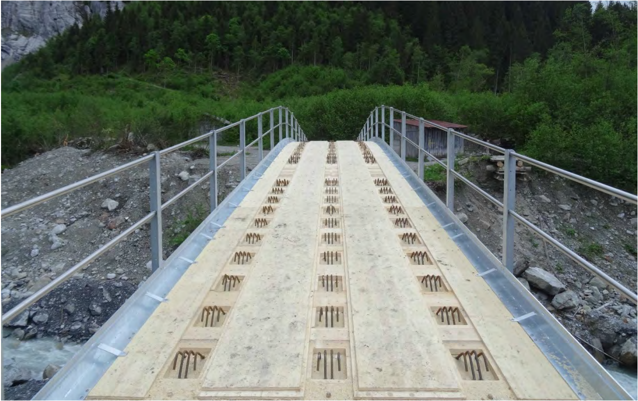
Fig. 2: Vorgefertigte Schalungselemente und eingeleimte Schubverbinder
