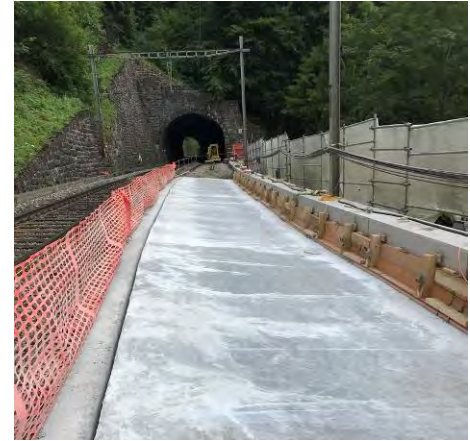
Fig. 5 Surface finie avant pose du ballast
