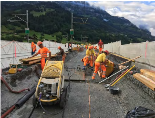
Fig. 9: Vorbereitungsarbeiten entlang der Bordüre
