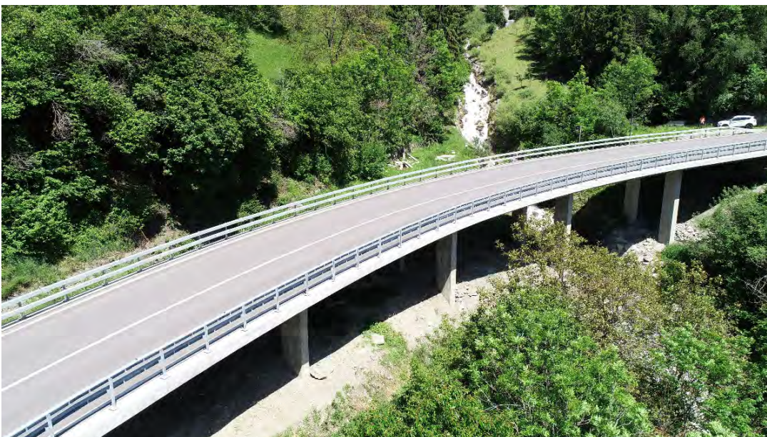
Fig. 1 : Pont de Bramois sur le torrent de Verbier
