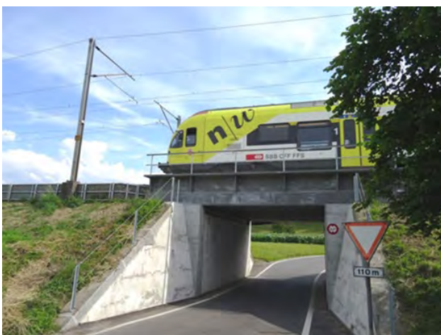
Bild 10: Ansicht der SU Unterwalden (Juni 2018).
