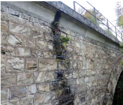
Fig. 3: Undichte Fuge
