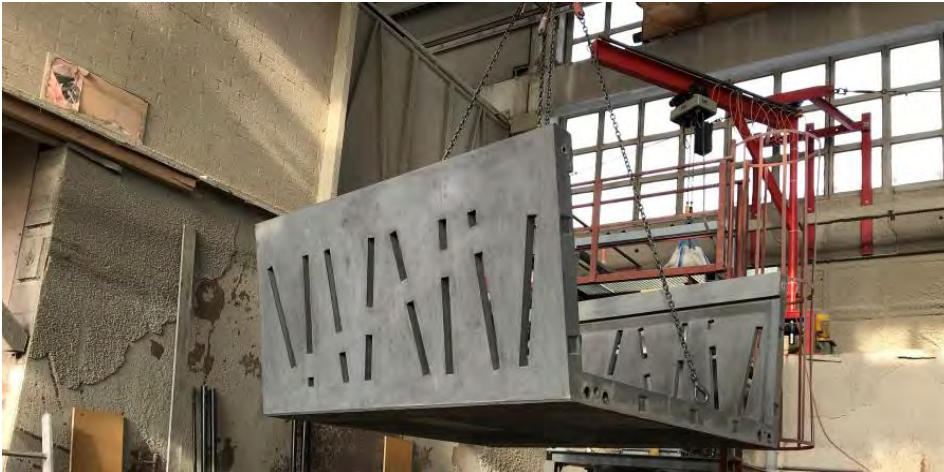
Fig. 7 : Manutention d'un élément après décoffrage
