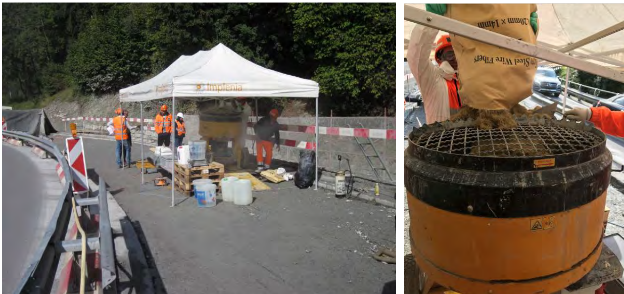
Fig. 5 : Centrale foraine et introduction des fibres dans le malaxeur
