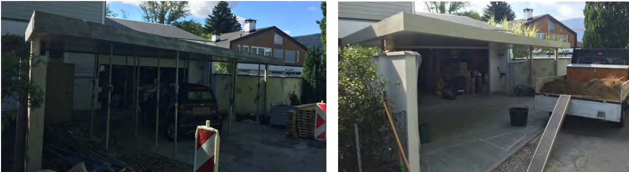
Fig. 6 Structure après décoffrage et après désétiage.
