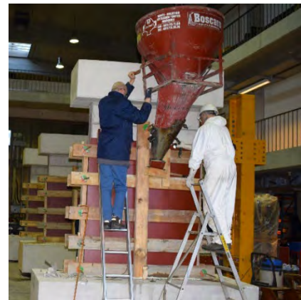
Fig. 6 : Coulage chemises BFUP
