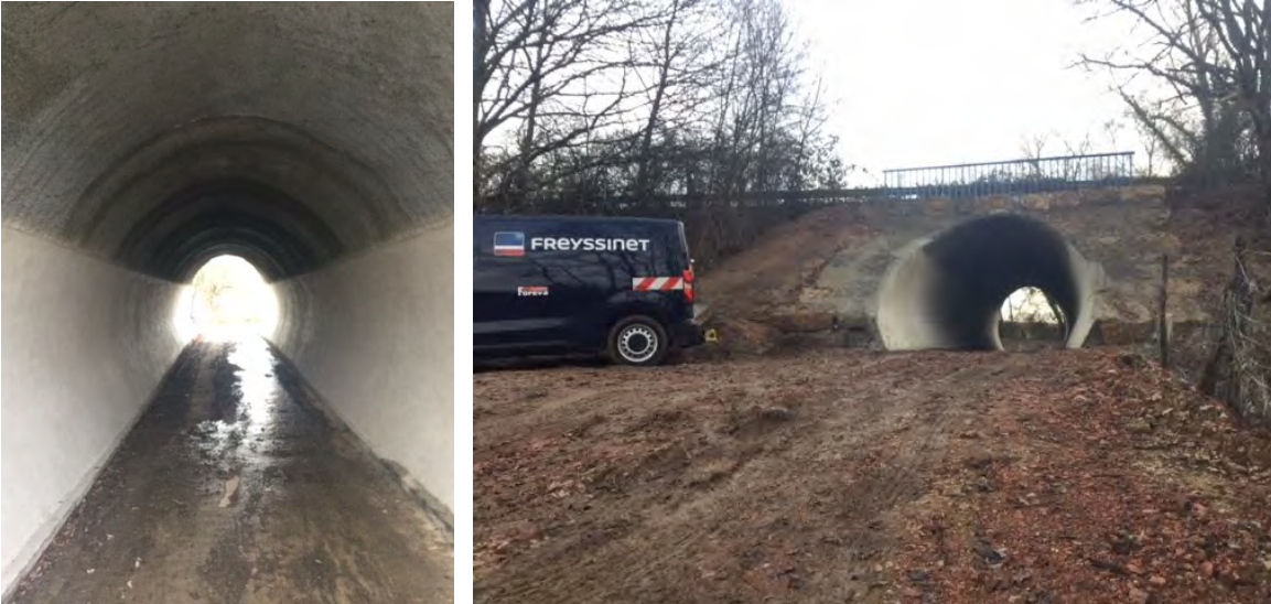
Figure 10 : Revêtement avec un enduit de finition
