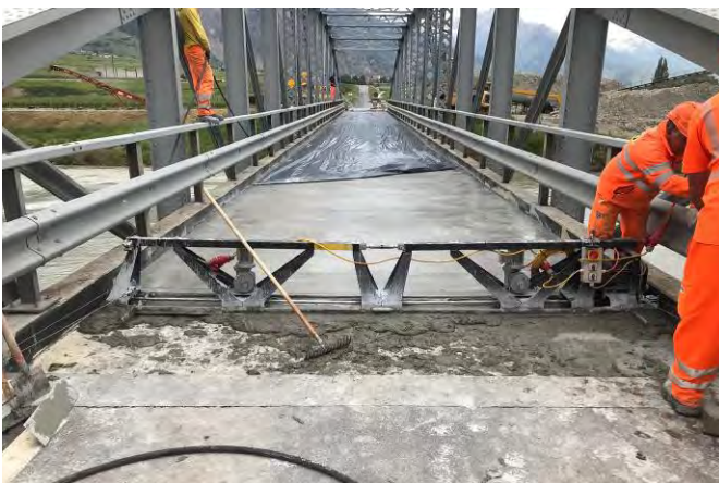
Fig. 8 Pose du BFUP à la règle sur toute la largeur
