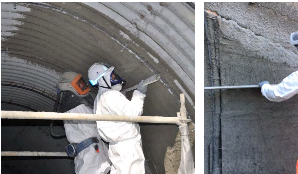
Figure 9 : Réglage de la surface à la règle
