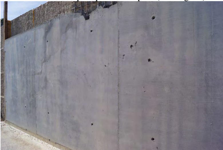
Fig. 22 : Mur après décoffrage
