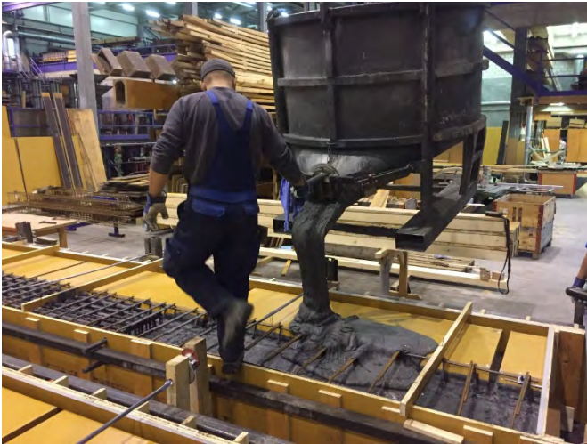
Bild 6: Einfüllen des flüssigen UHFB in eine Randträger-Schalung (Foto: Alphabeton AG)
