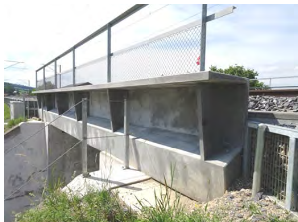
Bild 4: Seitenansicht des Randträgers aus bewehrtem UHFB
