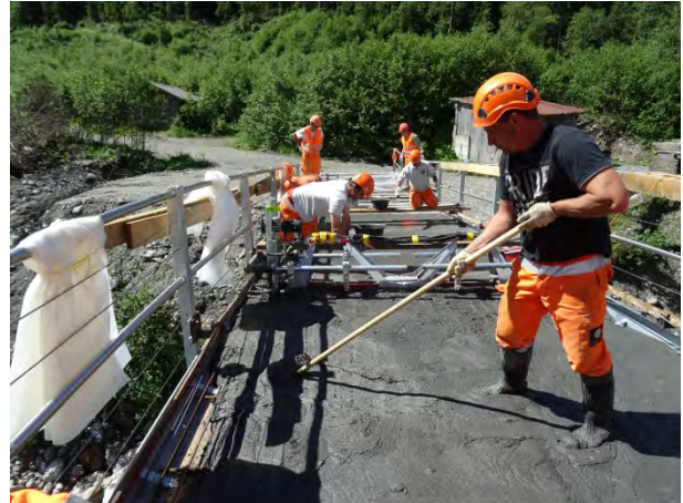
Fig. 5: Einbringung UHFB mit Tremixbalken
