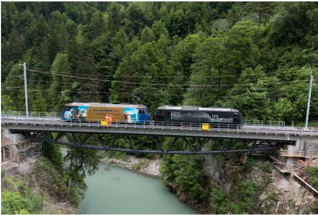
Fig. 6 BFUP sur tout l'auge et dans les joint
