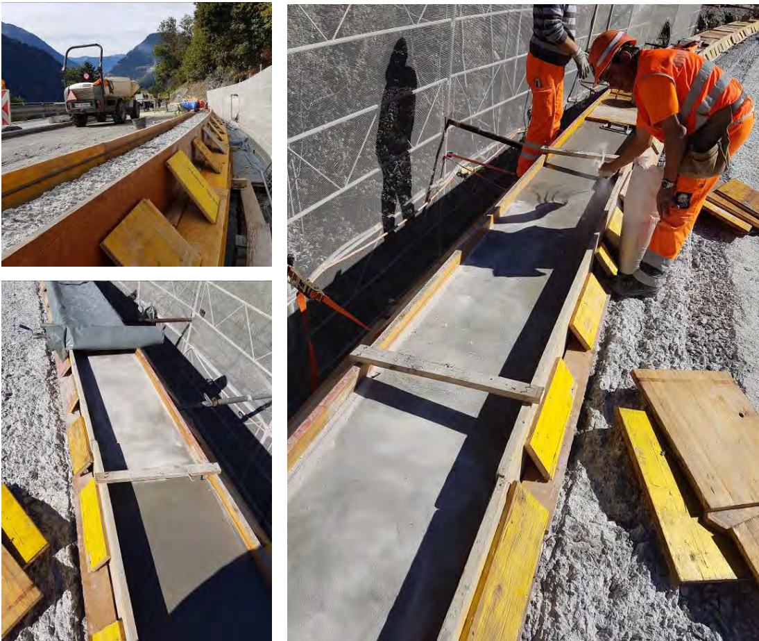
Fig. 7 : Réalisation du chemisage de la bordure
