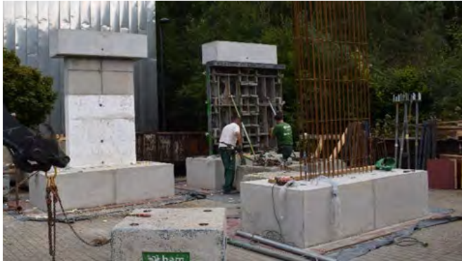
Fig. 3 : Réalisation voiles BA
