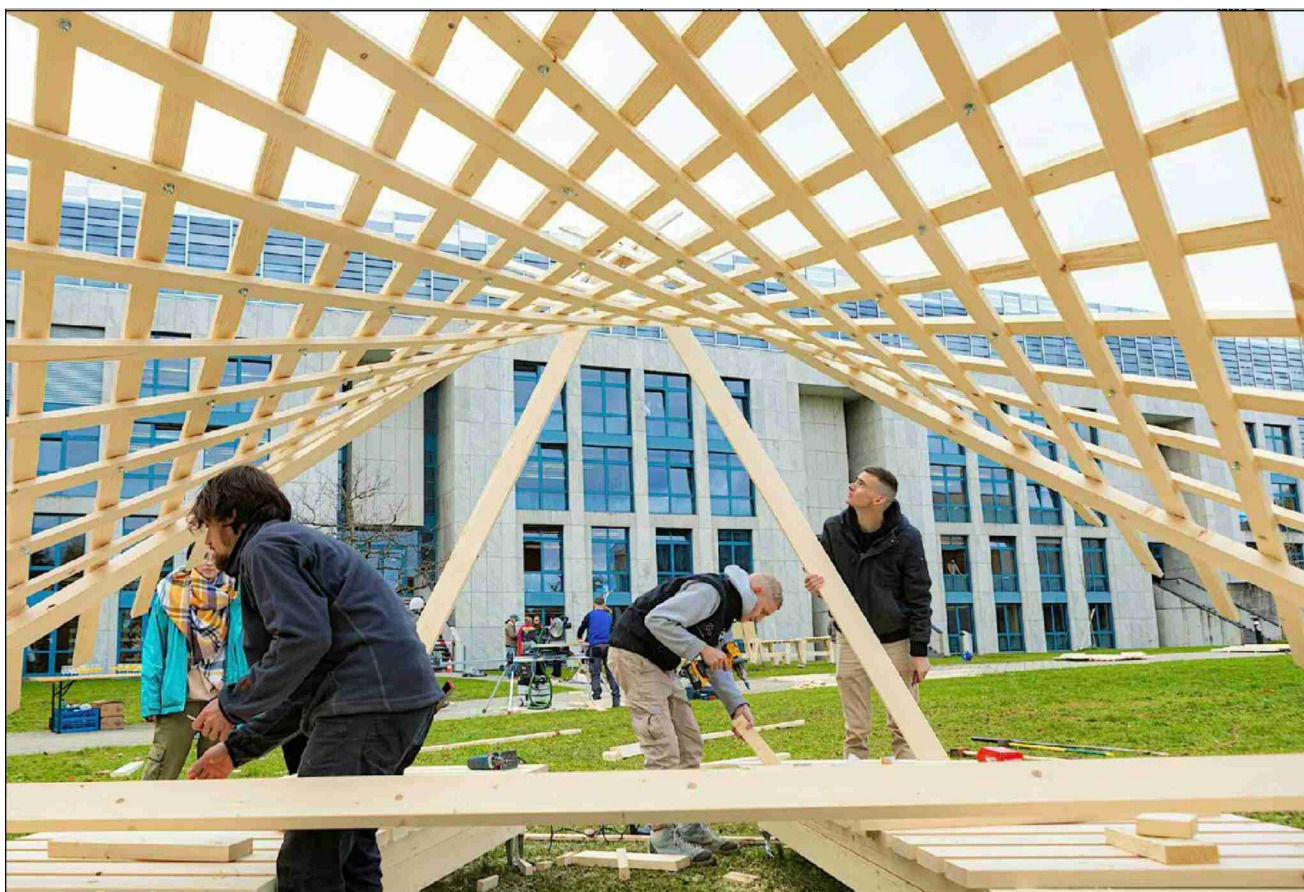
Les étudiants ont réalisé deux modules en bois dans les jardins du Collège du Sud à Bulle. CHLOÉ LAMBERT
