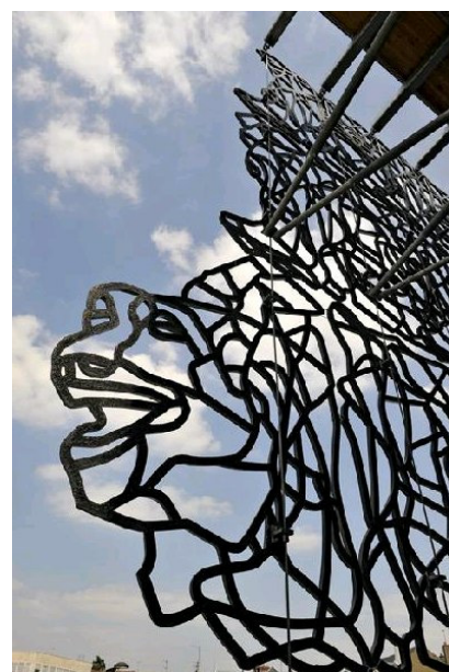
Figure 22 : Exemples de résilles en BFUP
