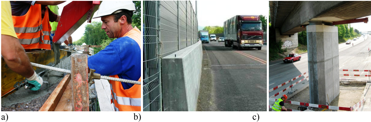
Bild 7 a) Einbringen des Frisch-UHFB, b) Ansicht der Leitmauer mit UHFB Beschichtung, c) vorfabrizierte UHFB-Schalenelemente ummanteln einen Brückenpfeiler.
