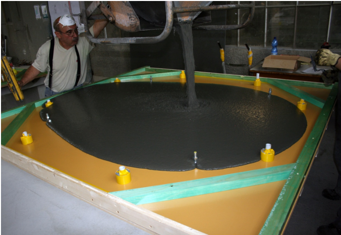
Abbildung 2.1. Betonieren einer Versuchsplatte
