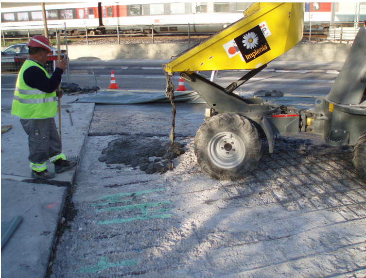
Fig. 5 : BFUP déversé directement sur la dalle depuis le dumper
