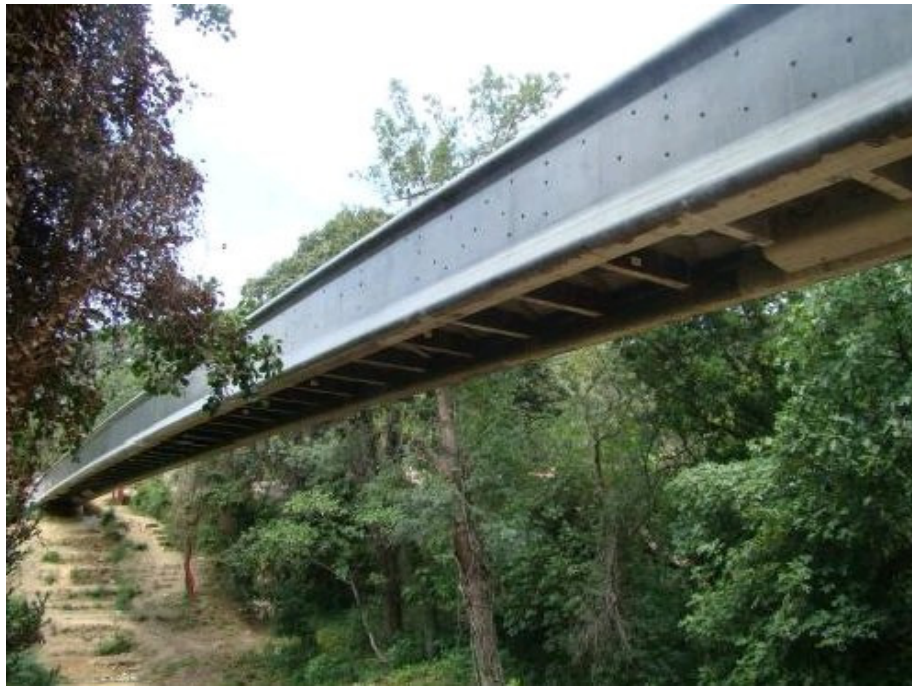
Figure 12 : Vue générale Passerelle des Anges
