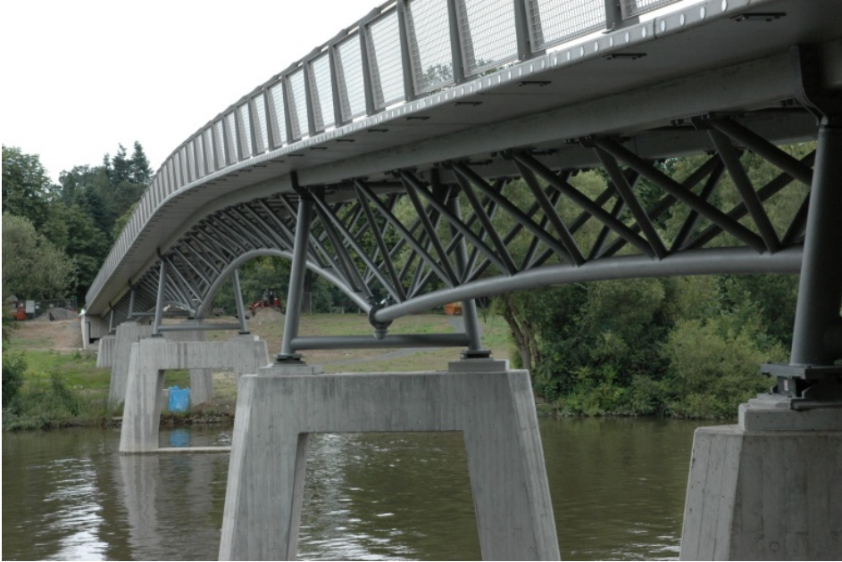
Bild 17 Gärtnerplatzbrücke nach ihrer Fertigstellung
