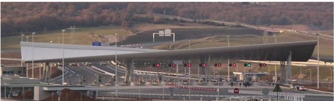
Figure 3 : Vue d'ensemble de la couverture de péage de Millau
