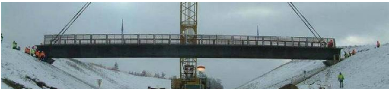
Abbildung 2.3. Überführung PS34 über Autobahn A51(F)
