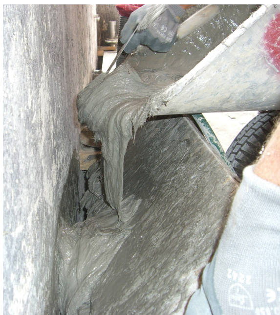
Fig. 12 Mise en place du BFUP des murs
