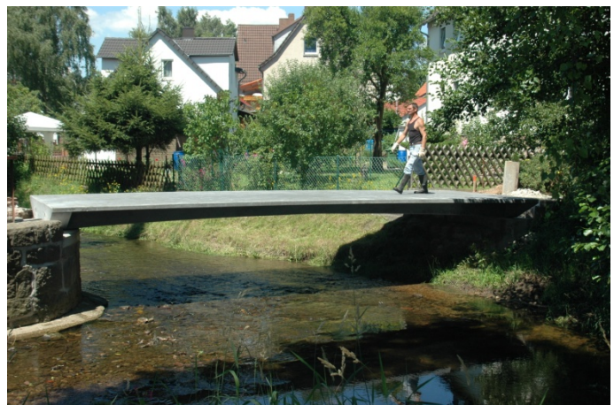
Bild 14. Querschnitt der zwei weiteren UHPC-Fertigteilbrücken über die Nieste (links), Ansicht nach der Fertigstellung (rechts)
