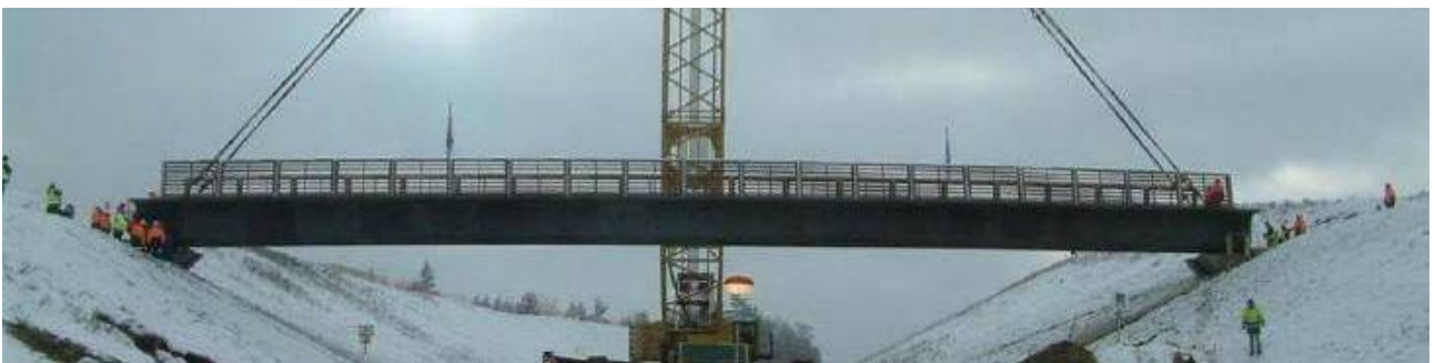
Figure 5 : Pont de la Chabotte sur l'autoroute A51 France, portée 47.4 m.
