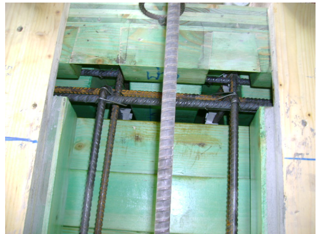
Fig. 7: Bewehrung Hauptbeanspruchung
