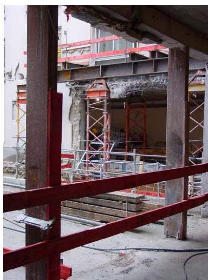
Figure 14 : Percement des façades et mise en place des nouveaux poteaux
