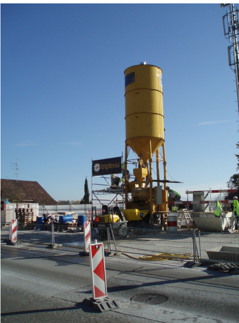
Fig. 3 : Centrale à béton avec silo à ciment – Capacité 500 L
