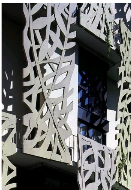
Figure 22 : Exemples de résilles en BFUP
