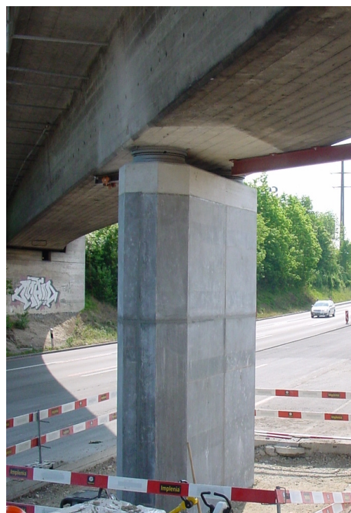
Fig. 7 Pile de pont après intervention
