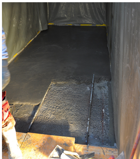
Fig. 13 Mise en place du BFUP du radier
