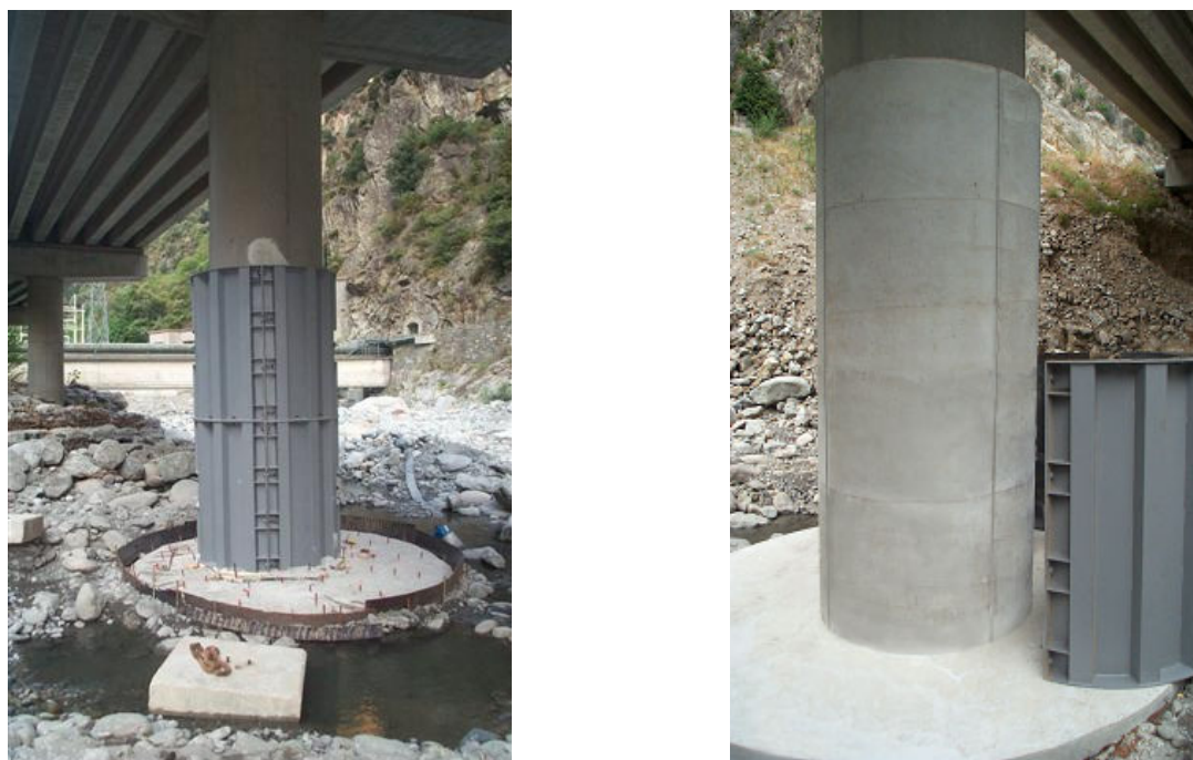
Figure 17 : Réparation et protection des fondations et appuis du viaduc de Valabres.
