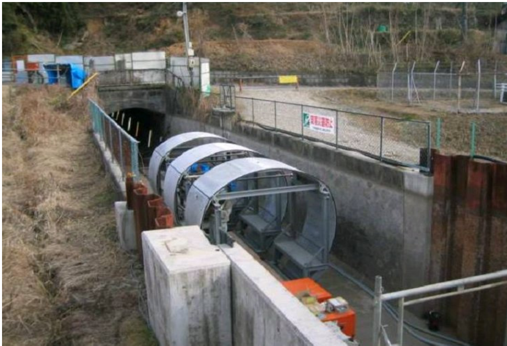
Figure 20 : Utilisation de Ductal ® en renforcement d'ouvrage hydraulique.
