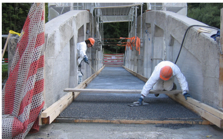
Fig. 3 Pont de Dalvazza en cours de réhabilitation
