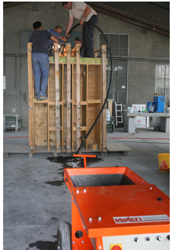
Fig. 18: Beton gepumpt
