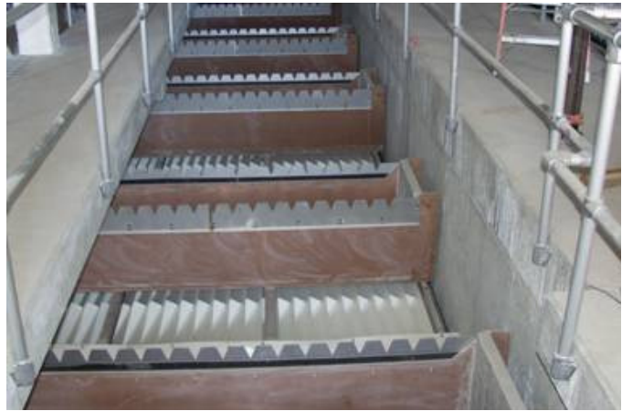
Figure 19 : Vue des tranchées après installation
