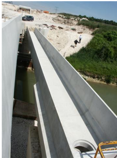
Figure 5 : Vue générale de l'aqueduc
