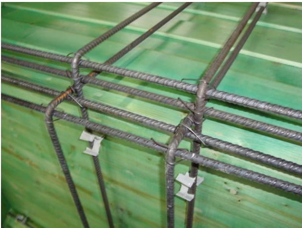
Fig. 6: Bewehrung in Winkelquerschnitt
