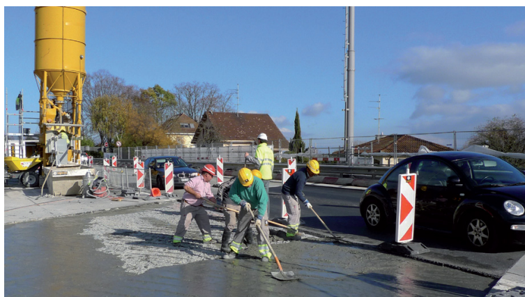
Fig. 6 : Mise en place et réglage du BFUP
