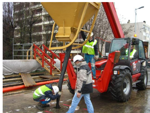
Figure 16 : Vues des opérations de bétonnage sur site
