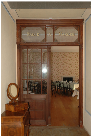
Fig. 25 La porte de la salle à manger réalisée en mélèze date de 1897. Elle conserve les inscriptions originales. © Pro Binntal
