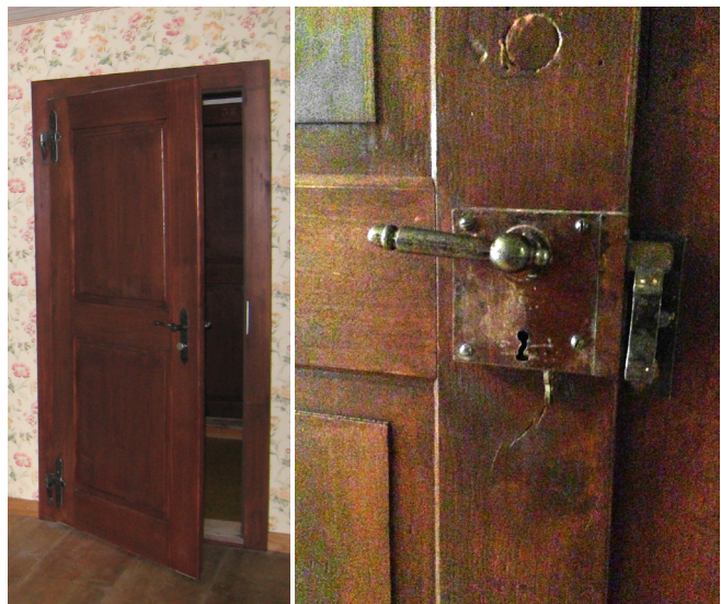
Fig. 26-27 Les portes des chambres ont été conservées et adaptées aux standards actuels. Certaines ont conservé les ferments d'origine. © EIA-FR
