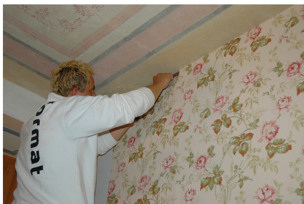
Fig. 66 Mise en place, dans la salle à manger, de papiers peints imprimés sur un appareil centenaire. © Pro Binntal
