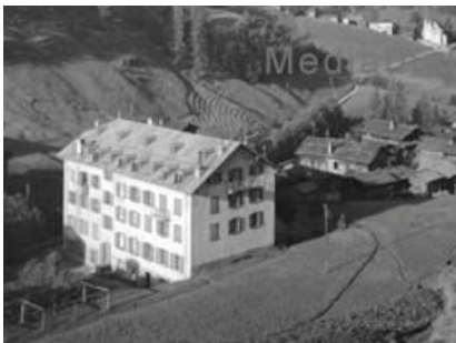
Fig. 34 Le volume de l'hôtel en 1935. © Charles Paris, Médiathèque Valais
