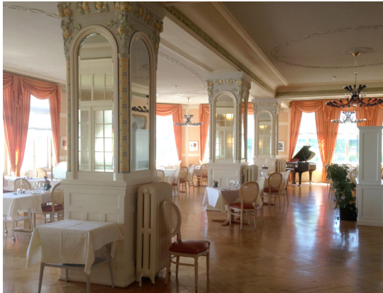
Fig. 22 Les murs et les piliers de la salle à manger ont conservé les lambris d'appui en bois peint. Le plancher d'origine recouvre l'entier de la salle. La polychromie des chapiteaux qui avait disparu a été rétablie en 1996 avec des tons moins soutenus que les couleurs d'origine 20 . Les lustres originaux ont disparu dans les années 1950. Une des fenêtres d'origine avec cadre en bois vient malheureusement de disparaître au profit d'une fenêtre isolante avec cadre en PVC. © EIA-FR
