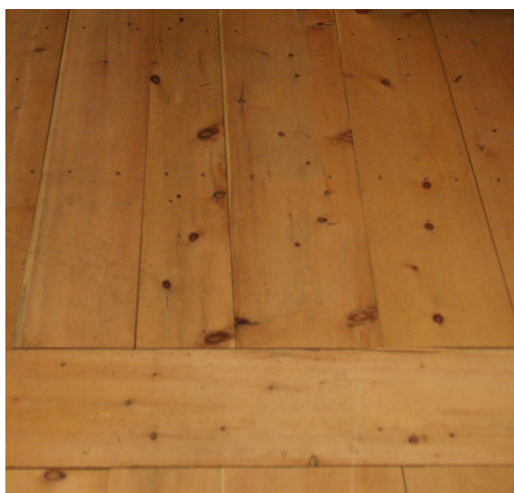
Fig. 21 Dans un des couloirs distribuant les chambres, les planchers n'ont pu être conservés. Ils ont été refaits avec soin. Des planches de bois de largeur irrégulière ont été clouées à la manière des planchers existants. © EIA-FR
