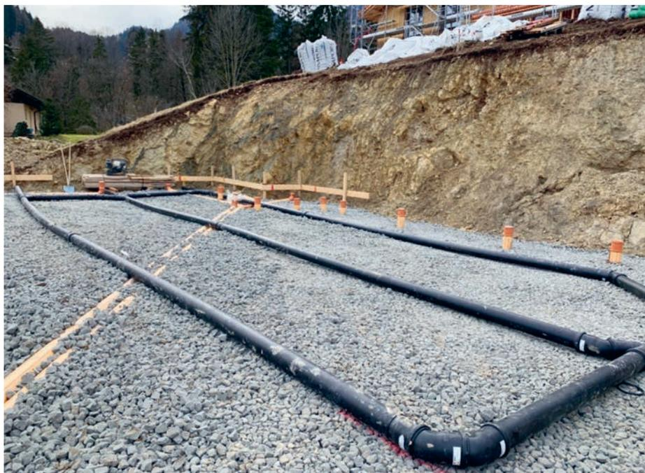
Fig. 2 : Mise en place d'un drainage du radon sous radier dans le cadre de la construction d'une nouvelle villa.
