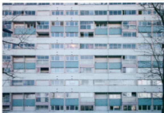
Palier avec des logements fermés dans un immeuble de quatre étages en attente de démolition dans le quartier d'Étouvie à Amiens (isabel concheiro, 2024)
