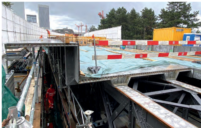
Abb. 5: Die gespiegelt identischen Stahl-UHFB-Trogelemente wurden auf den parallel angeordneten Zwillings-Stahlbrücken positioniert und mit der neuen Obergurtlamelle verschweisst. Der Quertugen wurden mit UHFB kraftschlüssig verschlossen. (Fotos: E. Brühwiler. 30.05. und 03.07.2024)
