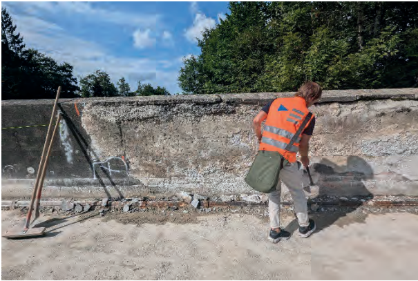
Abb. 10: Verputz und Fahrbahnbelag entfernt
