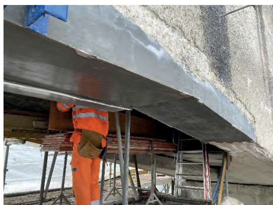
Abb. 19: Verankerung des UHFB-Zuggurts in der
