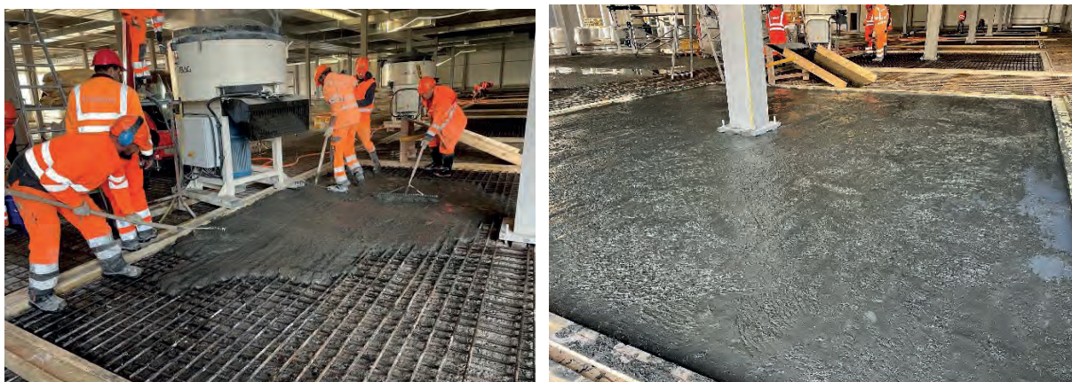
Fig. 10 : Mise en place du CFUP à l'aide de râpeaux (gauche) ; bétonnage d'une étape terminée avant protection (droite)
