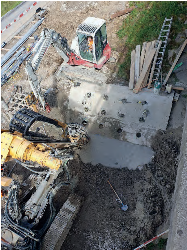
Abb. 13: Mikropfahlfundation
