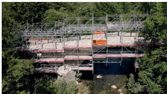
Fig. 4 : Vue de l'échafaudage suspendu, et place exiguë pour les travaux CFUP
