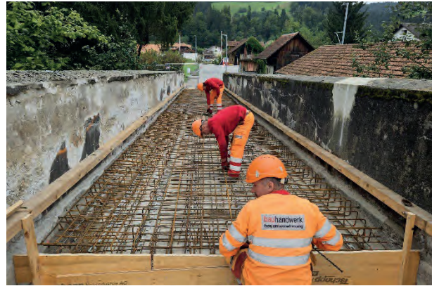
Abb. 11: Bewehren der Betonplatte im Randfeld
