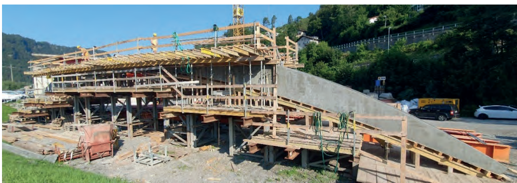
Abb. 20: Vorfabrikation in Ilanz
