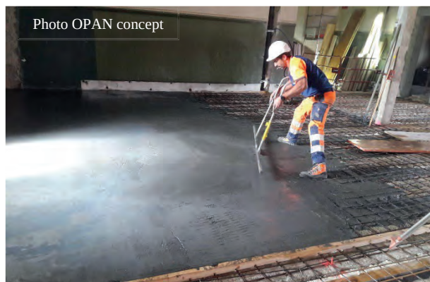
Fig. 13 : Mise en œuvre du CFUP
