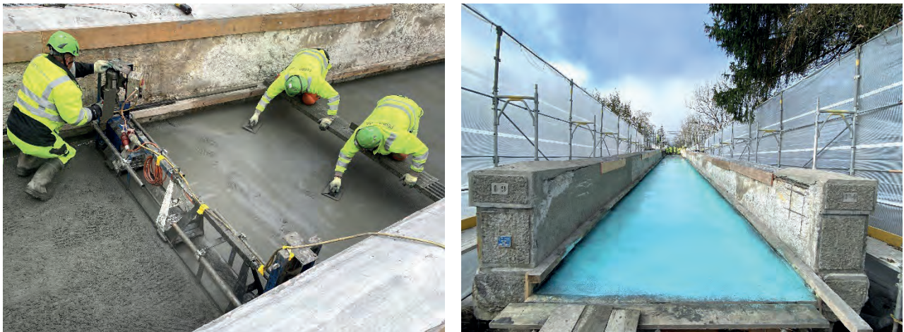
Abb. 14: Einbau des Belags in UHFB-Kiesmatrix Abb. 15: Verzögerer in blau als Nachbehandlung
