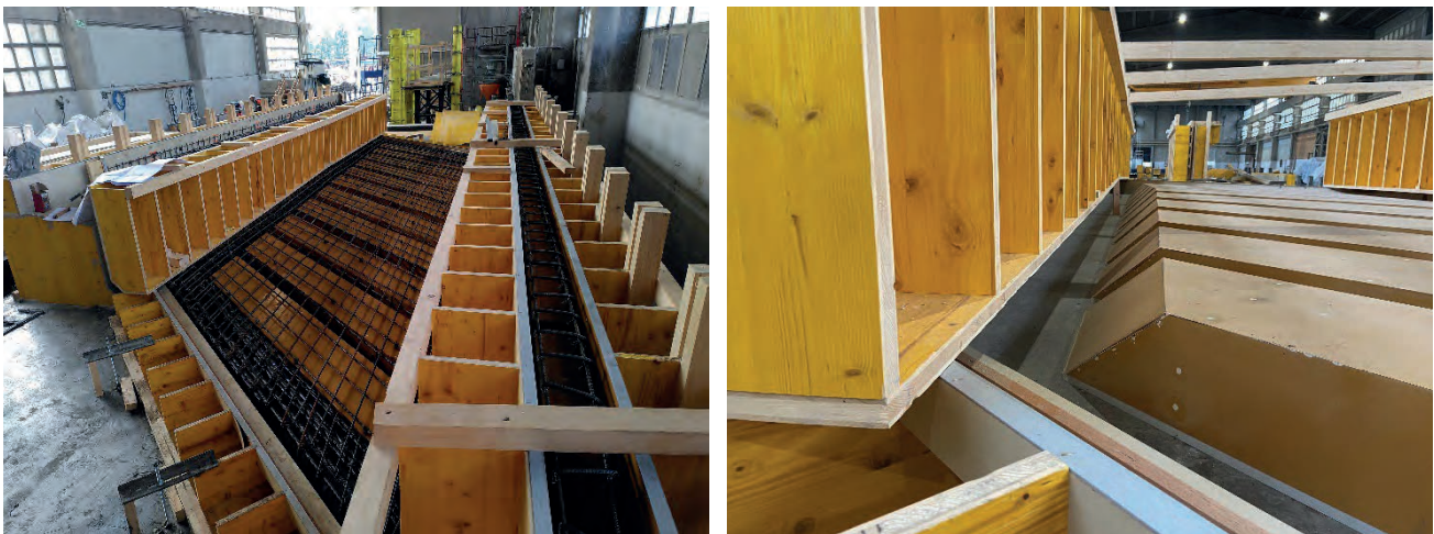
Abb. 7: Schalung und Bewehrung der Bahnbrücke
