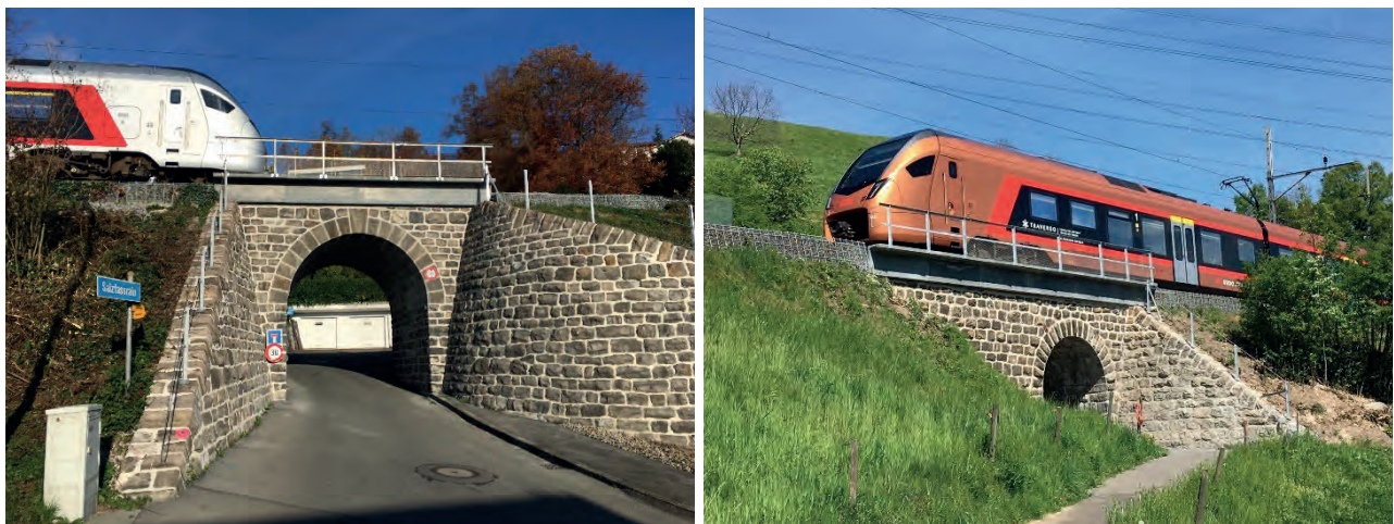
Abb. 36: und Abb. 37: DU Salzfass und WU Bürgenstock nach der Erneuerung
