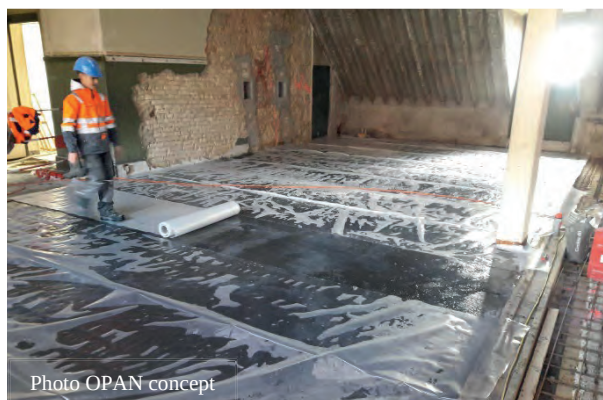
Fig. 14 : Cure à l'aide de feuilles plastiques
