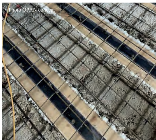
Fig. 8 : Surface supérieure de la dalle avant la mise en œuvre du CFUP
