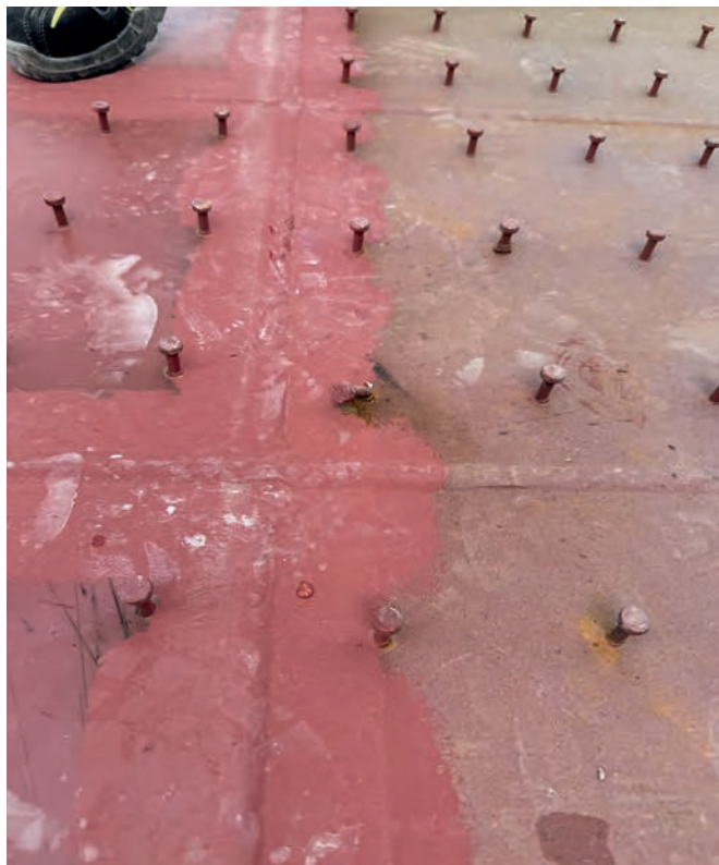
Fig. 5 : Aspect de la tôle de platelage au droit d'un joint de soudure (sablage effectué et peinture appliquée sur site au droit du joint de soudure)
