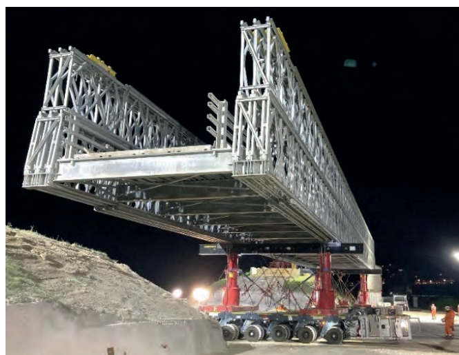
Fig. 19 : OCP de nuit - Dépose du pont provisoire
