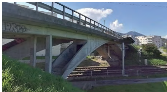
Abb. 4: Maillart-Brücke. Westlicher, seeseitiger Dreigelenkbogen, Foto 11.09.2021
