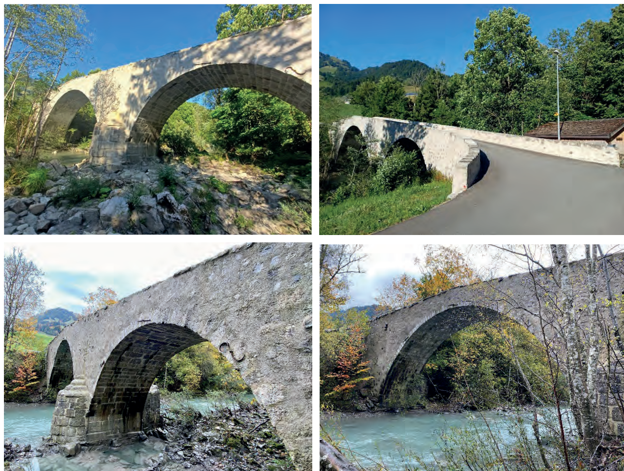
Fig. 9 : Aspect du pont « Rose-Marie » après la restauration (photos du haut, prises en juin 2025, et photos du bas, le 15 octobre 2024)
