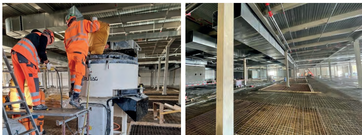
Fig. 9 : Préparation du mélange et malaxage (gauche) ; armature passive mise en place (droite)
