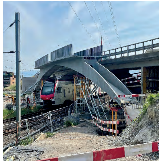
Abb. 22: Bogenelemente auf Hilfsabstützungen
