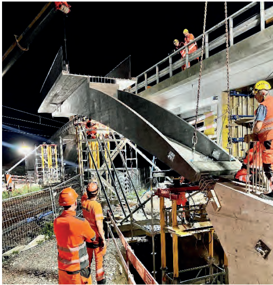
Abb. 21: Bogenelement am Kran
