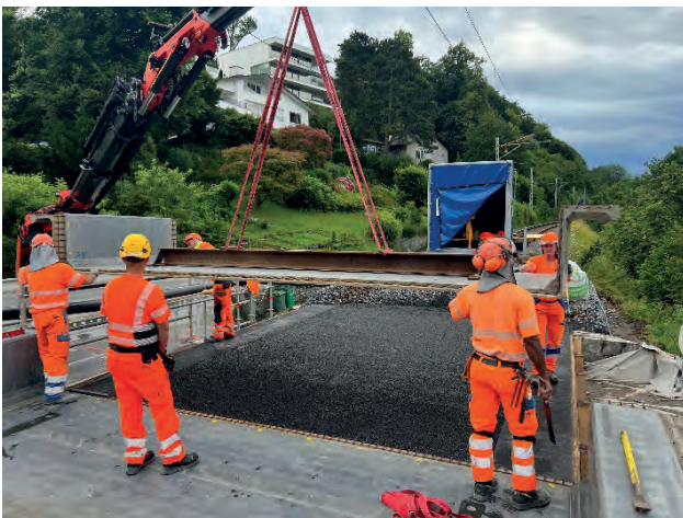
Abb. 32: Versetzen Elemente mit LKW-Kran
