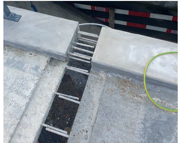
Abb. 19: Fuge nach Einhub
