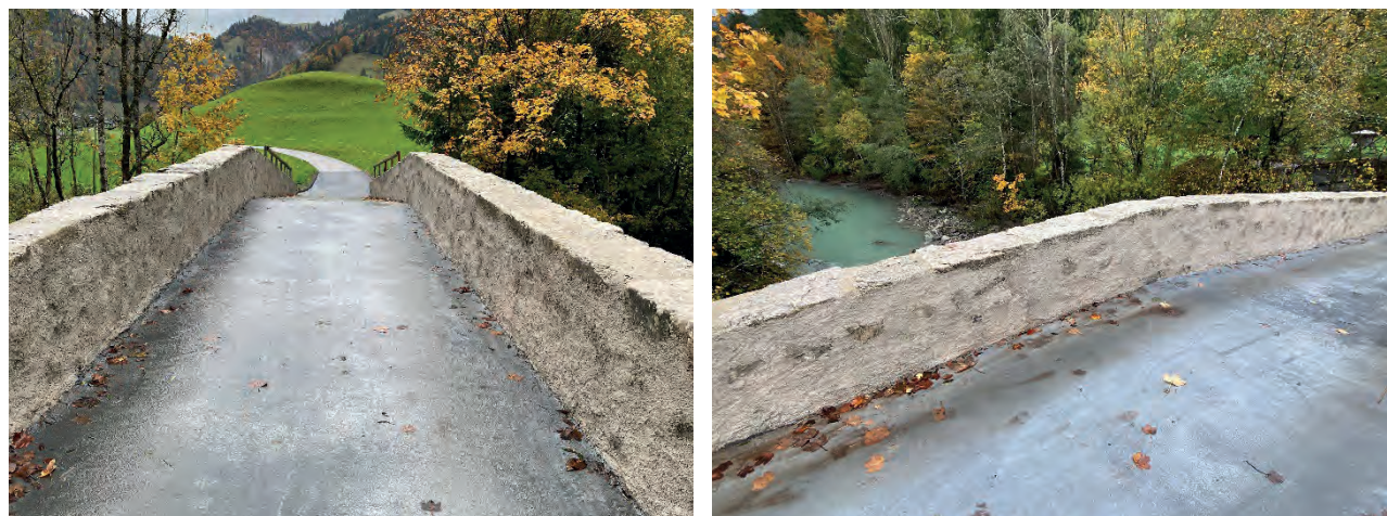
Fig. 8 : Aspect du revêtement en matrice CFUP avec gravillons (photos prises le 15 octobre 2024)
