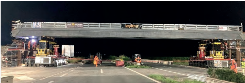
Fig. 21 : Mise en place du tablier – OCP de nuit
