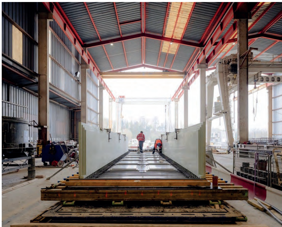
Fig. 7 : Photographie de l'usine de préfabrication – Réutilisation des négatifs en sous-face du tablier @ François Baudry
