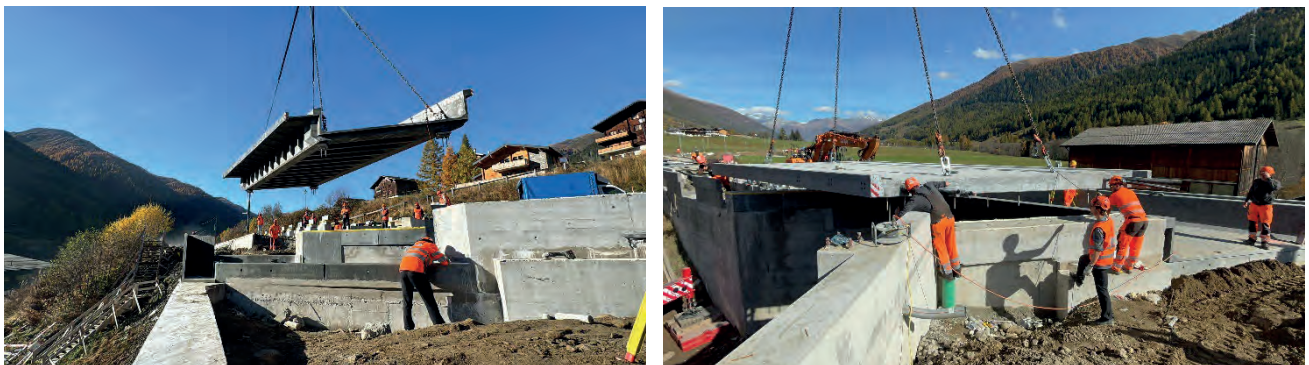
Abb. 9: Montage von Bahnbrücke (links) und Perronbrücke (rechts)
