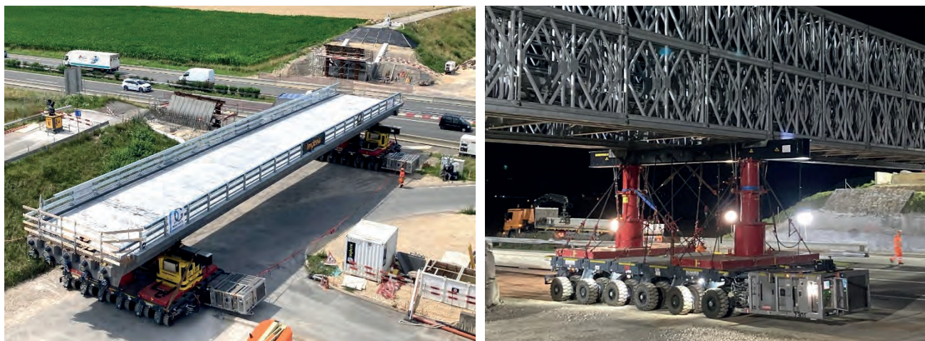
Fig. 5 : Logistique de chantier – chariots SPMT
