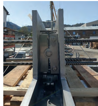
Abb. 9: Scheitелgelenk nach Produktion
