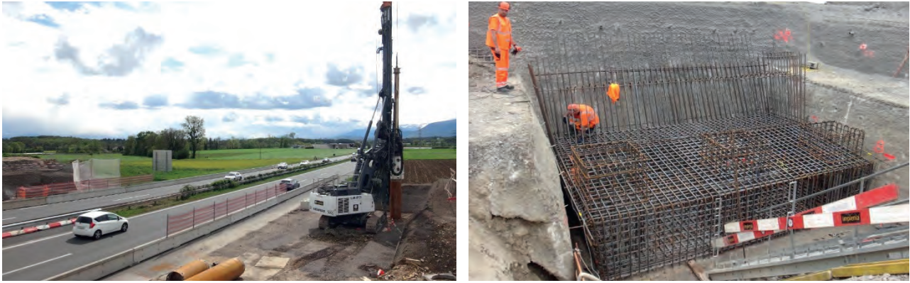
Fig. 20 : Travaux sur fondations et culées
