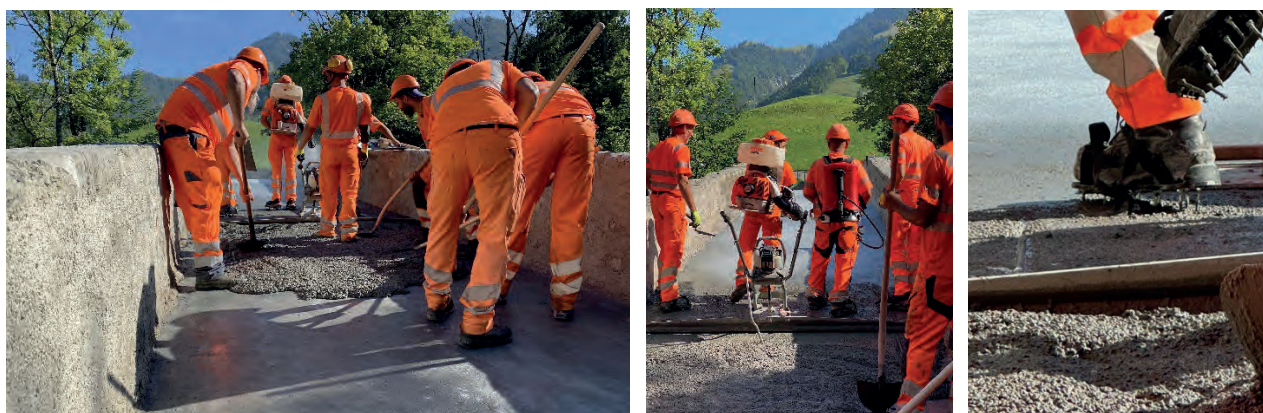
Fig. 7 : Mise en place du mélange de matrice CFUP avec gravillons sur fond CFUP traité au jet d'eau et humide, tiré avec une règle vibrante et application immédiate d'un produit de cure. Des chaussures spéciales avec des épines ont été utilisées afin de pouvoir marcher sur le CFUP gravillonné fraîchement mis en place. Photos prises le 22 août 2024
