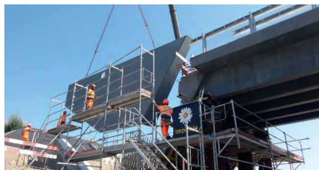
Fig. 24 : Peaux CFUP des culées et clavage
