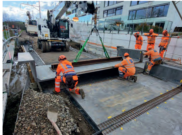
Abb. 31: Versetzen der Elemente mit Gleisbagger
