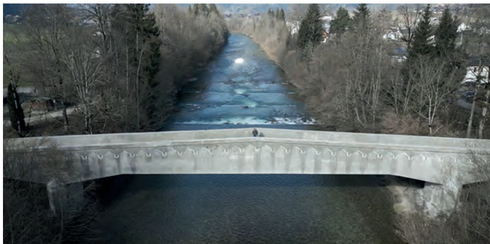
Abb. 4: Die Neumühlebrücke im Februar 2025.
