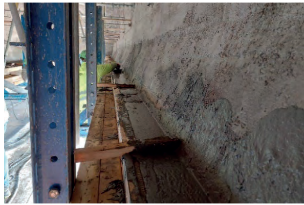
Abb. 17: Der geschalte und mit UHFB vergossene Untergurt
