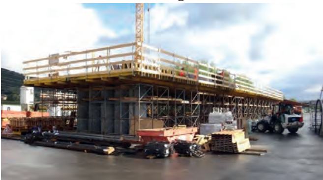
Fig. 17 : Cintre et coffrage du tablier, armature
