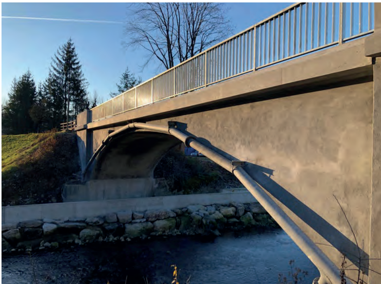
Fig. 6 : Vue du pont après remise en état
