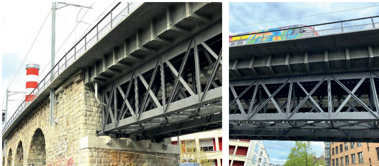
Abb. 6: Der UHFB-Schottertrug auf den genieteten Stahlträgern nimmt die filigrane Formensprache der ursprünglichen Stahlbrücken und Mauerwerkkrone auf und schreibt sie weiter. Die auskragende UHFB-Platte vereint die leichten, genieteten Stahl – UHFB Brücken mit dem massiven, jedoch filigran gestalteten Natursteinviadukt. (Fotos: E. Brühwiler, 16.04.2025)
