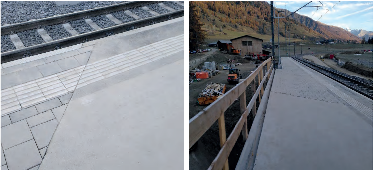
Abb. 2: Die integrale Planung beinhaltete auch die sorgfältige Ausgestaltung vom Übergang von Perron zu Perronbrücke (Fotos November 2024)
