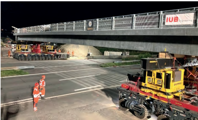
Fig. 22 : Déplacement du tablier pré-bétonné par chariot SPMT Opération de nuit avec fermeture de la N01 (SFO)
