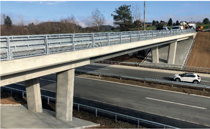
Fig. 1 : Nouveau passage supérieur de Chenaule
