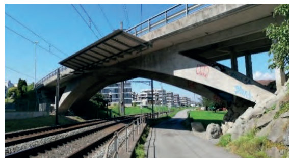
Abb. 5: Maillart-Brücke. Östlicher Dreigelenkbogen, Foto vom 11.09.2021
