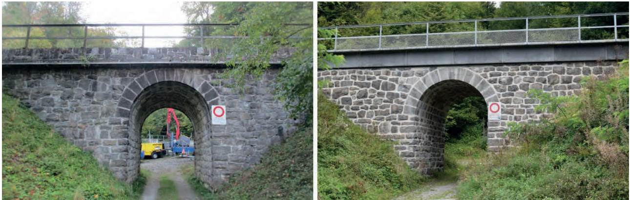
Abb. 34 & Abb. 35: Durchlass Seeburg in Luzern vor und nach der Erneuerung mit UHFB-Trog
