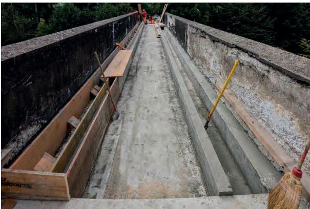
Abb. 12: Betonriegel im Mittelfeld
