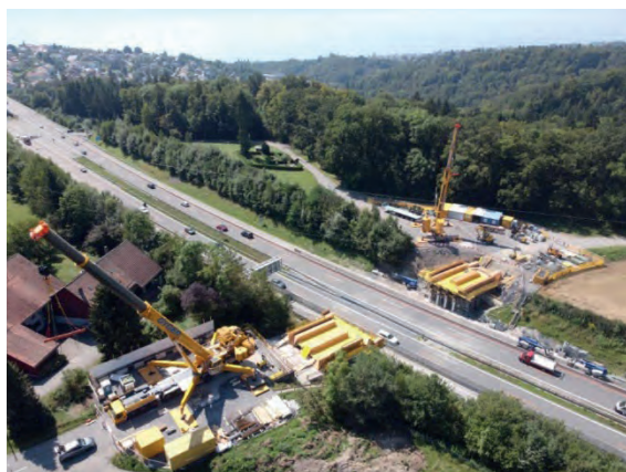
Fig. 10 : Emplacement prêt pour la pose ; Pose de la seconde poutre de 72 t
