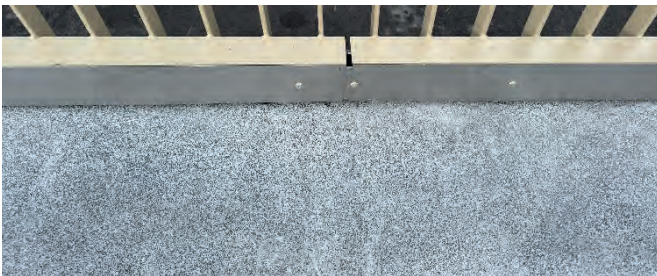
Fig. 11 : Aspect de la couche de revêtement en matrice CFUP
