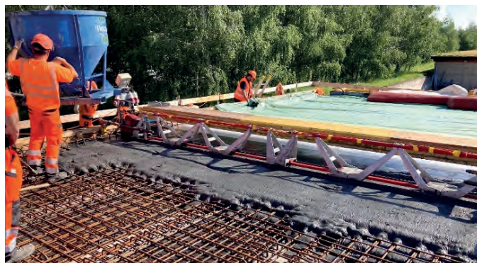
Fig. 18 : Mise en oeuvre CFUP type UB Tablier
