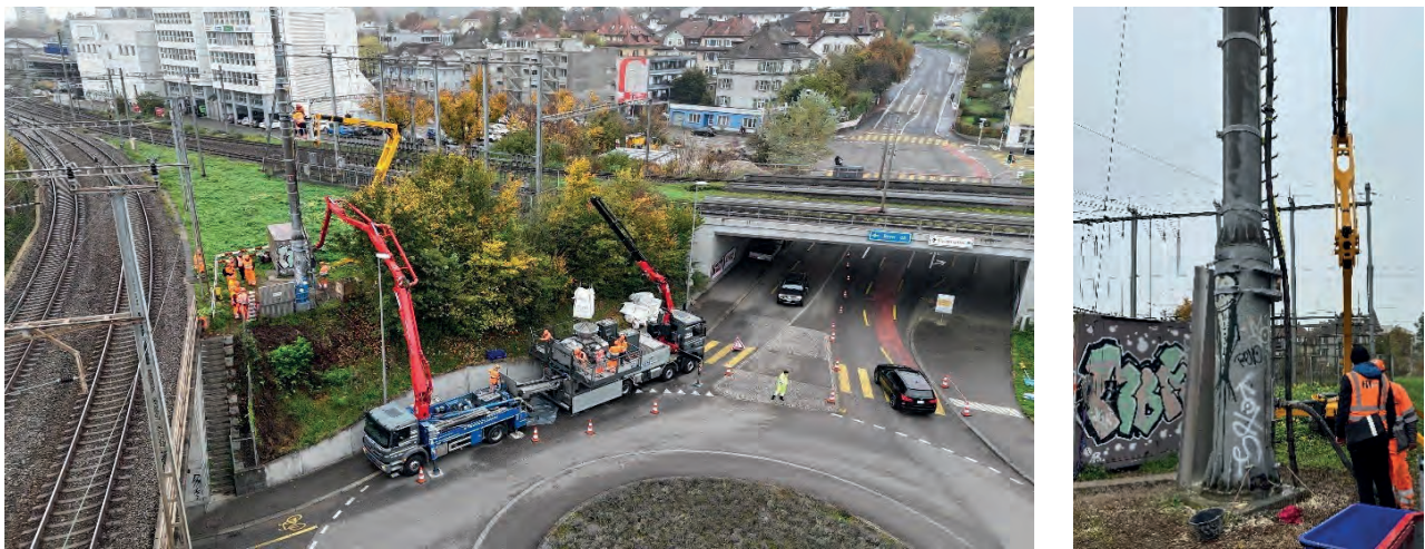
Abb. 9: Verstärkung Pilotprojekt mit dem MR-HT-SYSTEM ® , Baustelleneinrichtung (links) und Pumpvorrichtung bzw. Einfüllstutzen am Masten (rechts)
