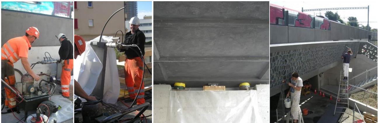
Fig. 11 Gauche : Mise en précontrainte, Centre : Vérins, Droite : Application de l'anti-graffiti
