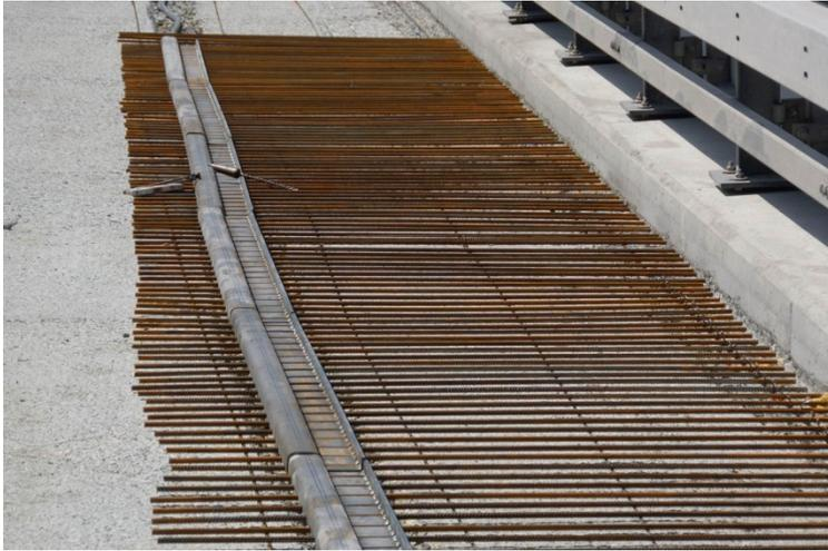
Die UHFB-Schicht wurde in Querrichtung schlaff bewehrt ( $\varnothing 12$  mm alle 100 mm), um die Fahrbahnplatte in dieser Richtung tragfähiger auszubilden. Im Bereich der Pfeiler erwies sich der Biegetragwiderstand in Längsrichtung als knapp ungenügend. Eine erhöhte UHFB-Schichtstärke von 50 mm über 25 % der Feldlänge sowie zusätzliche Längsbewehrung genügte aber, um auch diesen Nachweis zu erfüllen.
