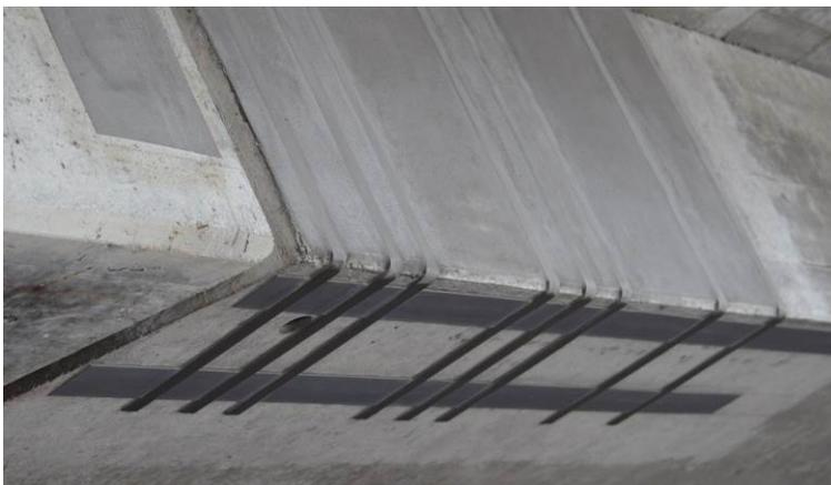
Die nachträglich angebrachte CFK-Verstärkung (Abb. 4) erwies sich bei der statischen Überprüfung als nur bedingt wirksam, da dadurch nur der äusserste Steg verstärkt werden konnte. Ausserdem war das Hauptproblem nicht durch mangelnde Querkraftbewehrung sondern vor allem in einer mangelnden Verankerung der Längszugkraft bedingt.
