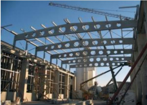
Fig.1 Poutres ajourées en béton
