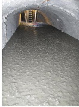
Fig. 7 Renforcement au cisaillement par le remplissage des évidements
