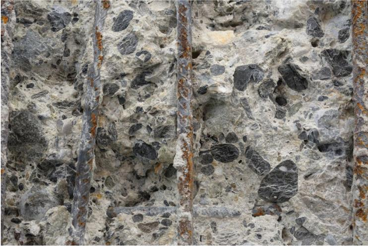
Die Fahrbahnplatte des 1969 eröffneten Viadukts der Autobahn A9 sollte ursprünglich mit herkömmlichen Baustoffen instandgesetzt werden. Doch bei den 2012 ausgeführten Hochdruck wasserstrahlarbeiten an den Unterseiten der Kragarme wurden Anzeichen einer Alkali-Aggregat-Reaktion (AAR) im Beton entdeckt, sodass das Bundesamt für Strassen (Astra) sein Erhaltungskonzept revidieren musste.
