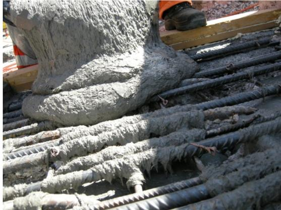
Fig. 1 Mise en place de BFUP lors de la remise en état de joint de chaussée
