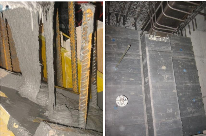
*Abb.4 Vergiessen der Wandschalung mit Holcim 707 links im Bild und aus-geschalte Wandverstärkung im Bild rechts (2015)*
