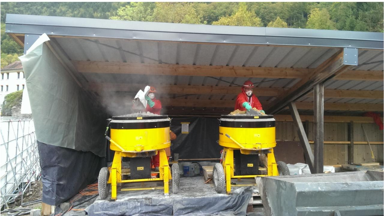
*Fig. 10 Fabrication du BFUP sur chantier*
