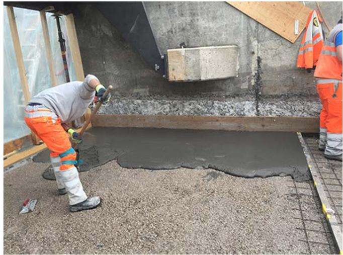
*Abb.7 Einbau des UHFB auf den zum Schutz vor kalten Temperaturen eingehaust und auf ca. 15 °C temperierten Schwellen*
