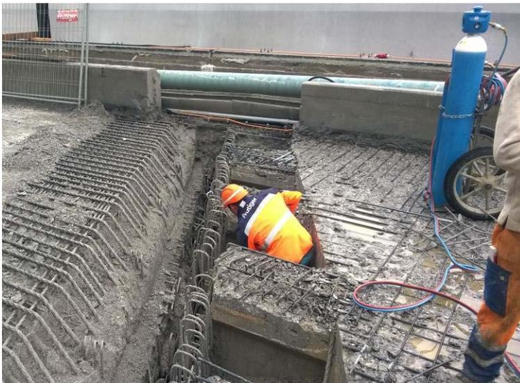
Die untere Bewehrung im Endquerträger wurde dabei für einen besseren Verbund mittels einer UHFB-Plombe einbetoniert. Für diese Plombe wurde der fliessfähige Beton Holcim 707 verwendet.
