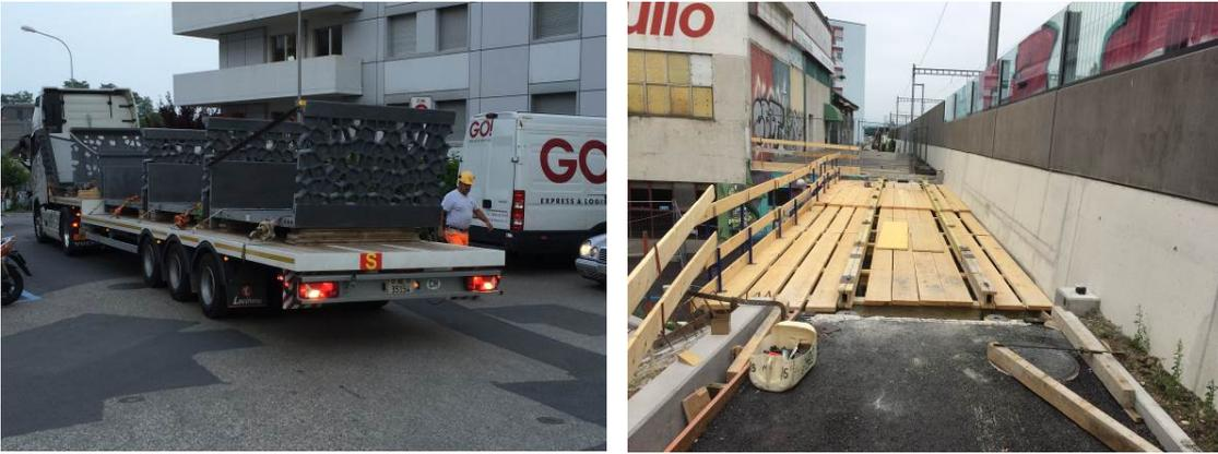
Fig. 8 Gauche : Transport par camion ; Droite : Cintre avec cales de compensation
