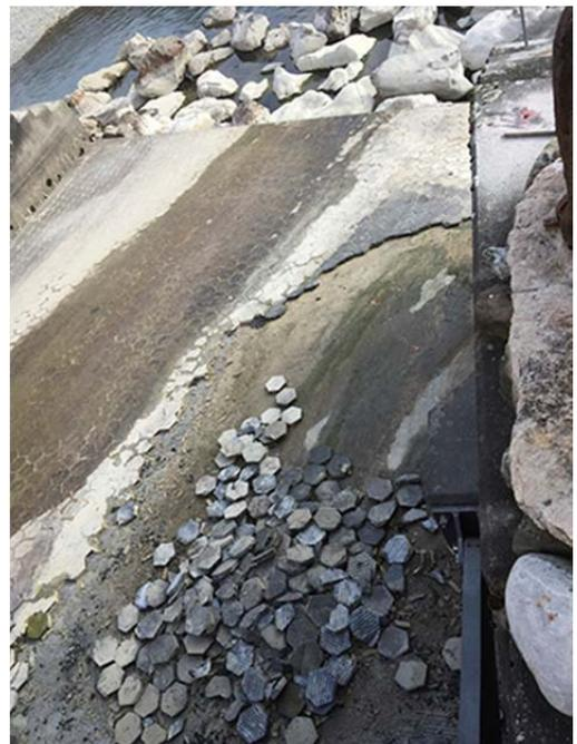
*Abb.6 Schadensbild an den Schwellen in Form grossflächig abgelöster Schmelzbasaltplatten*
