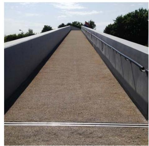
*Abb.10 Blick auf die Gesamtansicht der Passerelle ouvrage 39 links und Eindruck der Gefälleneigung von 13 % an der fertig instandgesetzten Fussgängerbrücke mit Splitteinstreuung rechts im Bild (2015)*
