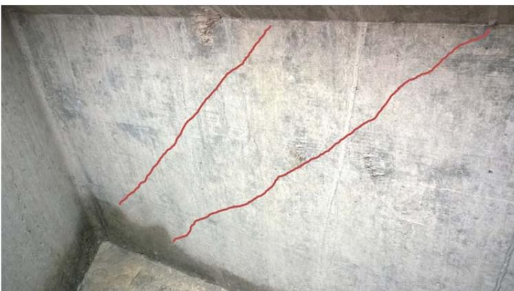
Abb. 16 Schubrisse in den inneren Trägerstegen (links)
