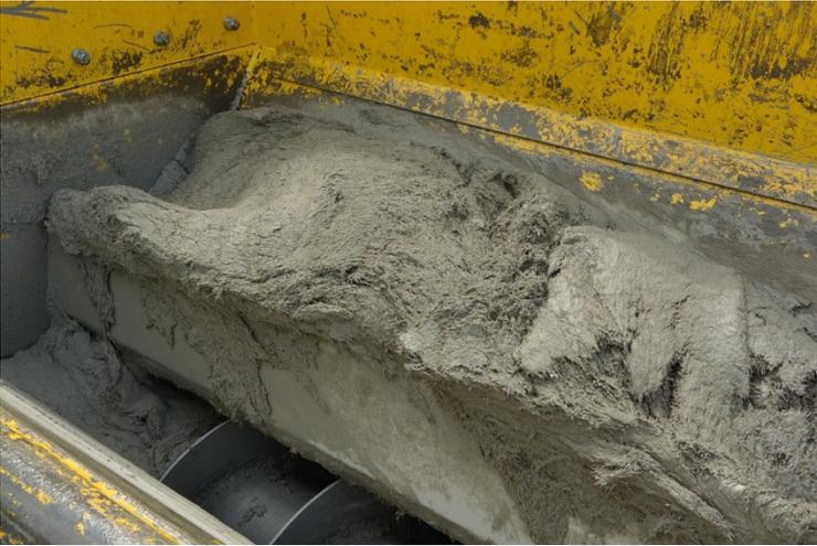
Abb. 11 Thixotroper UHFB im Fertiger
