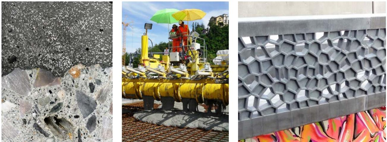
*Abb. 1 Links: UHFB und Beton, zwei offensichtlich sehr unterschiedliche Baustoffe (Ausschnitt eines UHFB – Beton Verbundquerschnitts); Mitte: maschineller Einbau von UHFB zur Verstärkung einer Autobahnbrücke; Rechts: „organischer“ Steg einer Fussgängerbrücke.*
