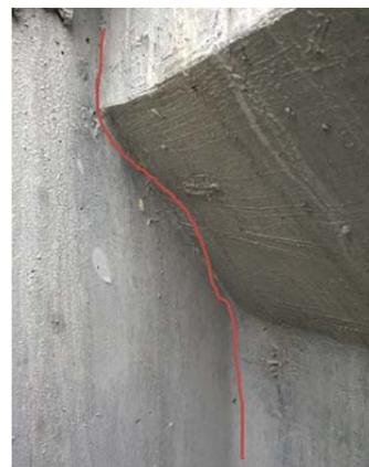
Abb. 17 Vertikale Risse im Auflagerbereich Verankerung der Längszugkräfte (rechts)
