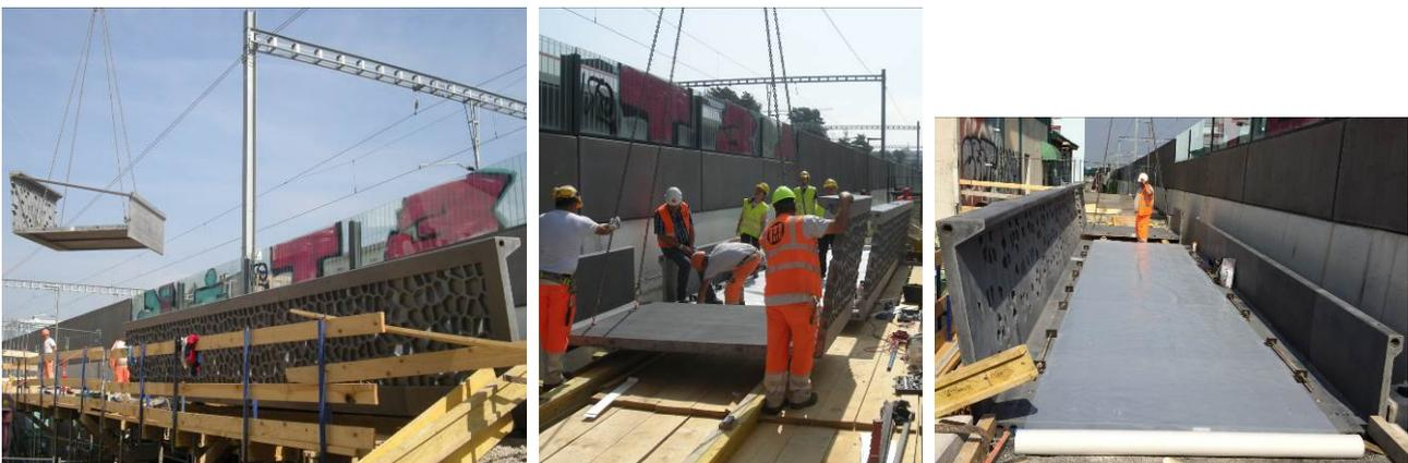
Fig. 10 Gauche et centre : Suite de la pose, Droite : Serrage provisoire des éléments entre eux
