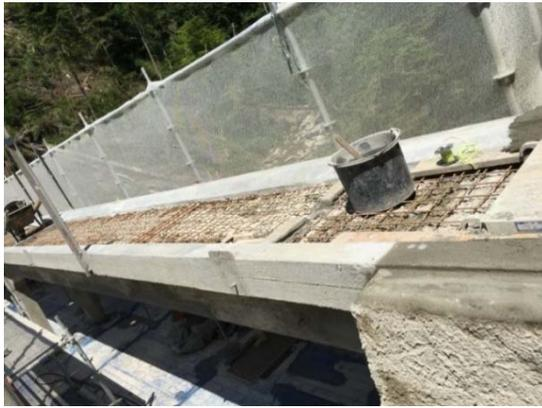
*Abb.9 Hebeltobelbrücke vor der Beschichtung mit UHFB (konventioneller Beton mit Bewehrungsnetz) links im Bild und fertig instandgesetzte Brückenplatte mit heller Splitteinstreuung in gelungener Ausführung (2015) rechts im Bild*
