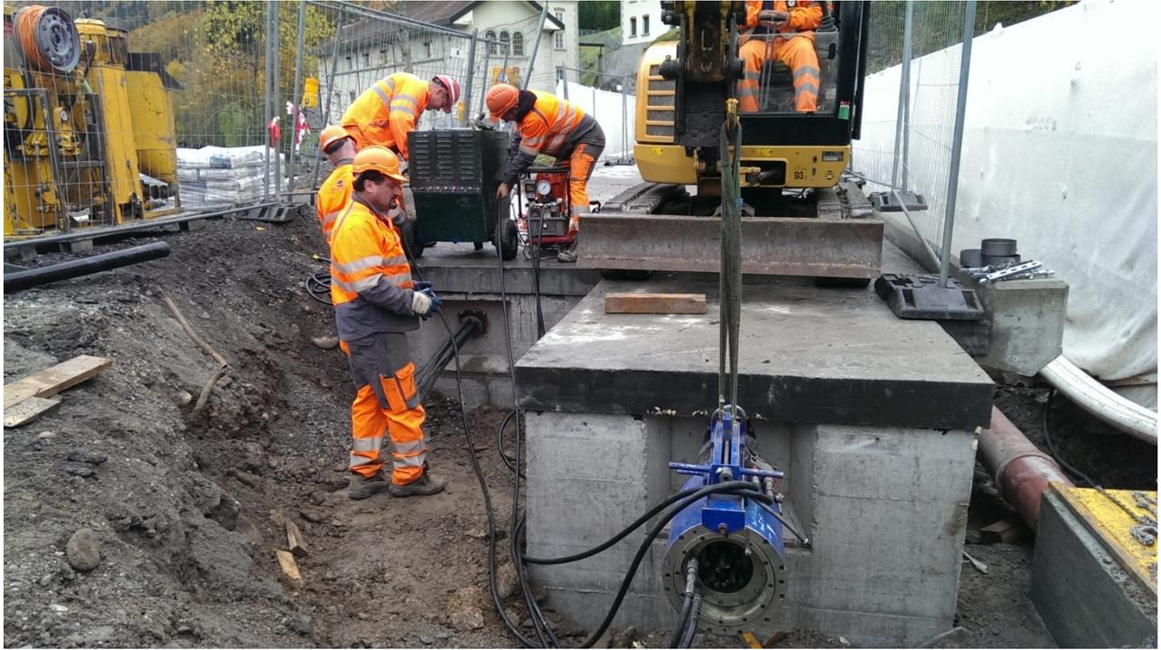
*Fig. 11 Mise en tension de la précontrainte extérieure*
