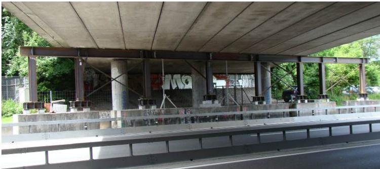
Diese Unterstellung erlaubte es in einem zweiten Schritt, die vorfabrizierten Träger der Brücke anzuheben und das Gerbergelenk freizulegen. Insgesamt wurde die Brücke mit ca. 1'500 Tonnen aufgepresst, um die Eigenlasten abzufangen. Dadurch konnte das Gerbergelenk aufgehoben und biegesteif mit dem Rest der Brücke verbunden werden.
