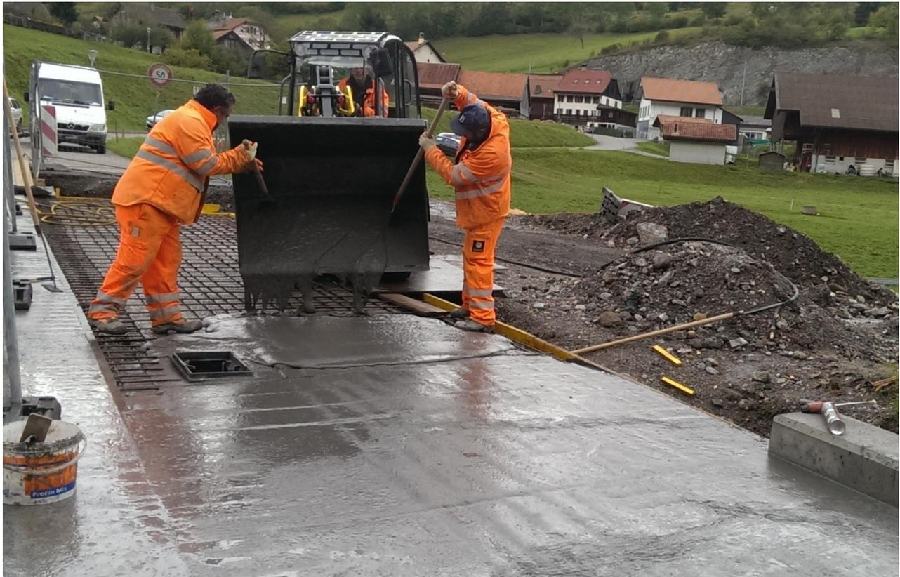
Fig. 8 Mise en place du BFUP
