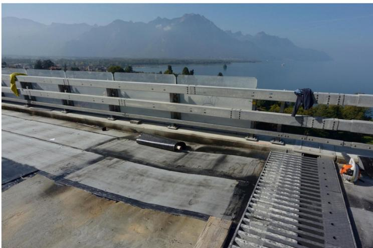
Abb. 16 Geklebte Dichtungsbahnen
