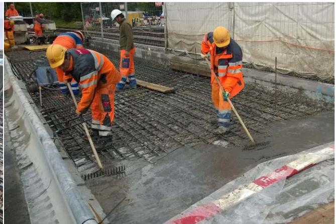
Abb. 15 Einbau UHFB Deckschicht
