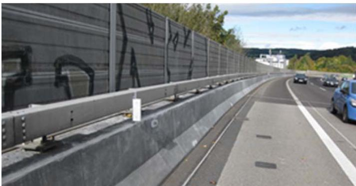
*Abb.2 Bauwerksinstandsetzung N01, Effretikon-Ohringen, Tössbrücke Winterthur Instandsetzung der Leitmauer (2014 /2015)*
