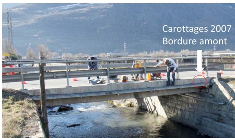
Abb. 4 Ansicht der Strassenbrücke über die Morge bei Sion (Foto aufgenommen am 10. März 2014 bei der Probekörperentnahme).
