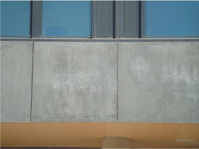
*Fig. 1 Inhomogénéité de surface et taches blanches sur la surface coffrée de pièces en BFUP réalisés avec des moules en bois vernis.*
