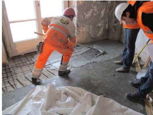
Fig. 5 Mise en place d'une couche de renforcement en BFUP sur dalle nervurée
