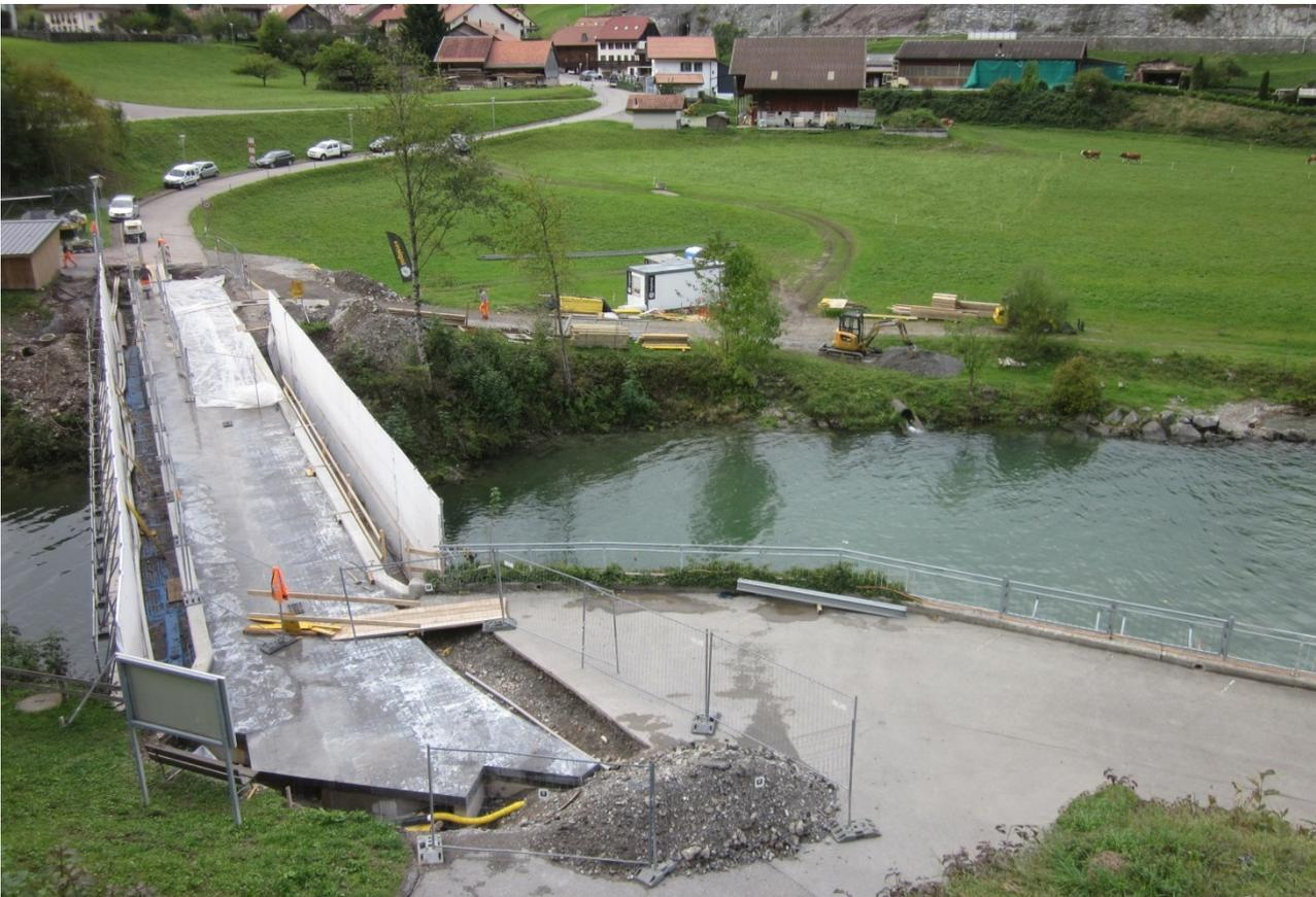
*Fig. 7 Vue de la cure de la dernière étape de bétonnage du tablier en BFUP*
