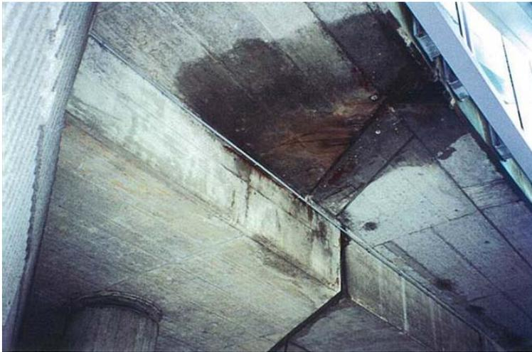
Insbesondere der Bereich des Gerbergelenks war vor der Instandsetzung 2004 undicht (Abb. 3).
