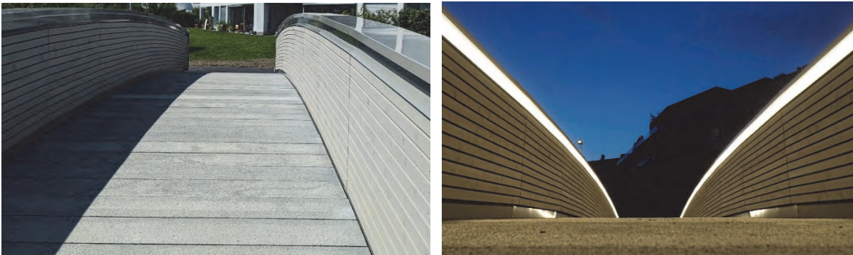
Abb. 8: Draufsicht auf die UHFB-Gehwegplatten mit seitlichen, verschalten Holzträgern und Lichtband unter dem Handlauf zur Beleuchtung der Gehwegfläche
