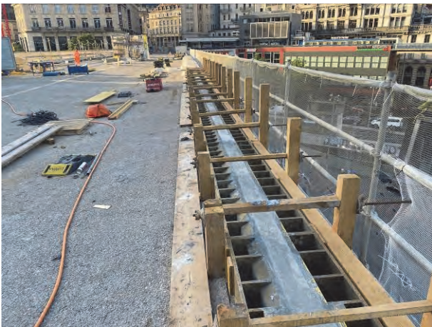
Fig. 9 Vue du bétonnage de la bordure CFUP (photo INGPPI 2022)
