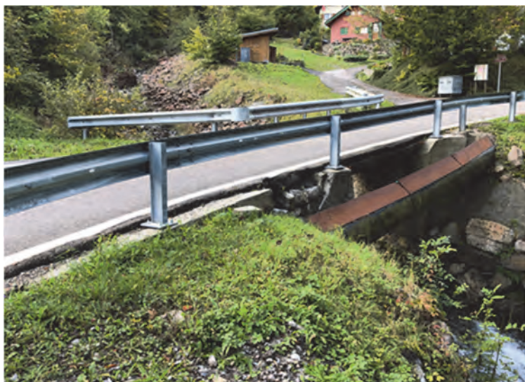
Fig. 1 : Pont existant de Clarive avant les travaux
