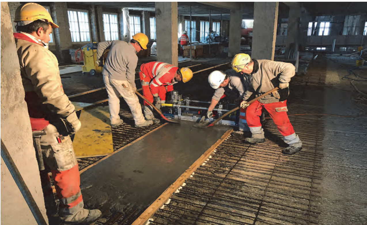
Abb. 9: Einbau des UHFB
