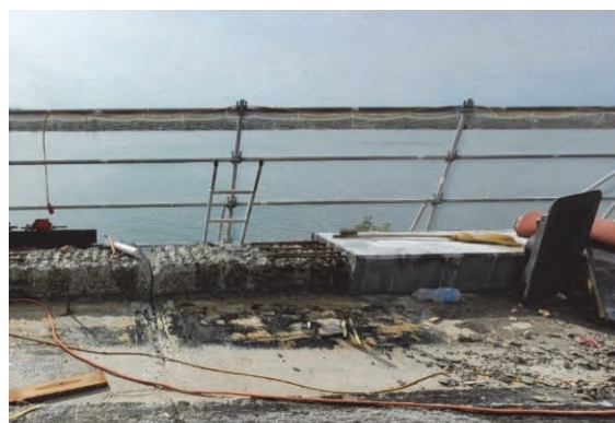
Fig. 10 : Bordure de l'ouvrage NB 74 : Préparation du support et joint de reprise
