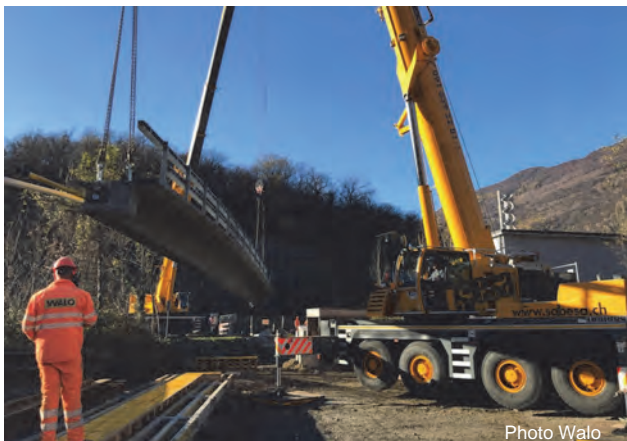
Fig. 14 : Levage et mise en place d'une poutre de bord. Celle-ci est munie de sa bordure, du dispositif de retenue et de toutes les conduites de tiers
