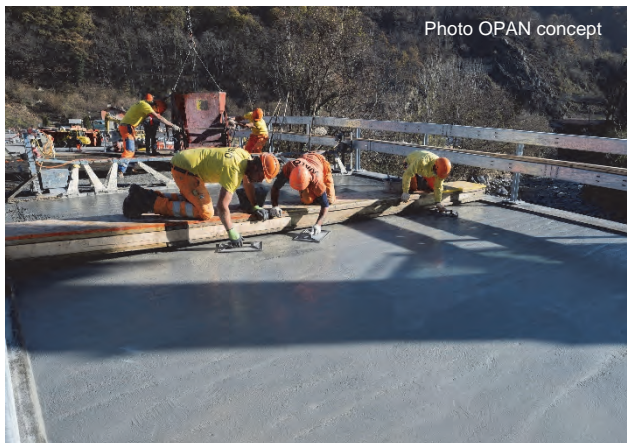
Fig. 15 : Réalisation de la surcouche et des dalles de transition, servant de couche de roulement définitive
