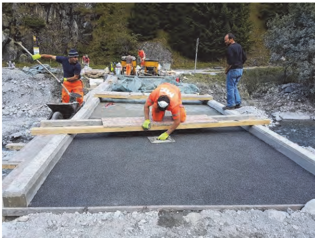
Fig. 16 : Réalisation du revêtement par saupoudrage des gravillons et aspect après 5 ans
