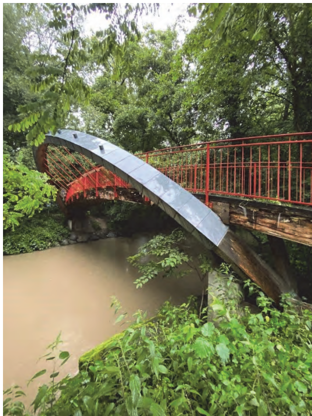
Fig. 2 : Vue de l'ancienne passerelle en bois (photo INGPHI 2021)
