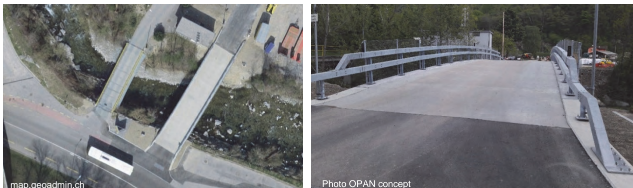
Fig. 17 : Vue aérienne de l'ancien pont à déconstruire et du nouveau pont en CFUP (photo de gauche) et vue de la surface de roulement en CFUP
