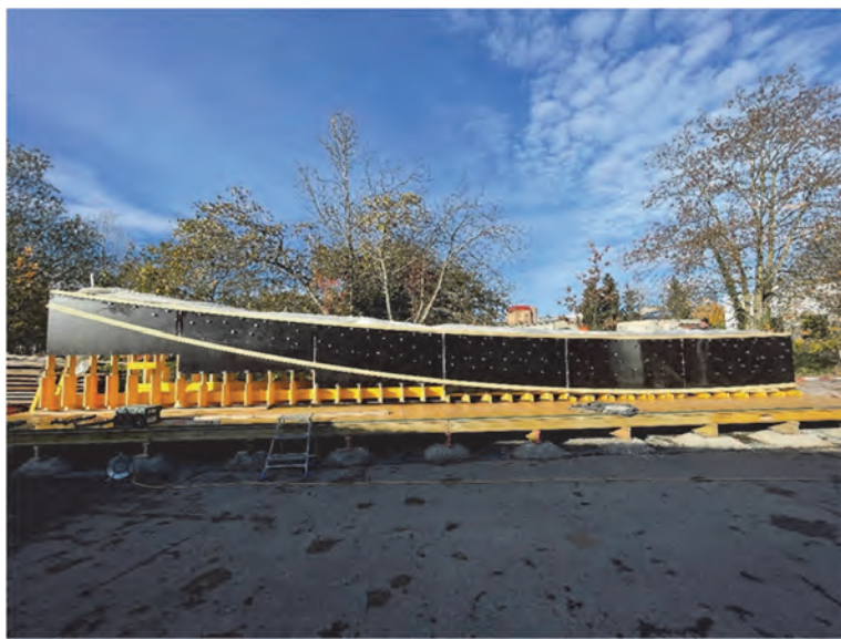
Fig. 8 : Vue partielle du coffrage
