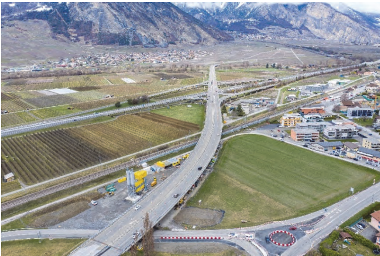
Fig. 1 : Vue d'ensemble du viaduc de Riddes
