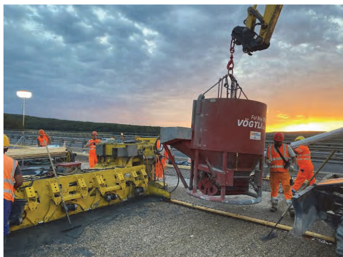
Abb. 1: Pont d'Ouche, UHFB-Einbau
