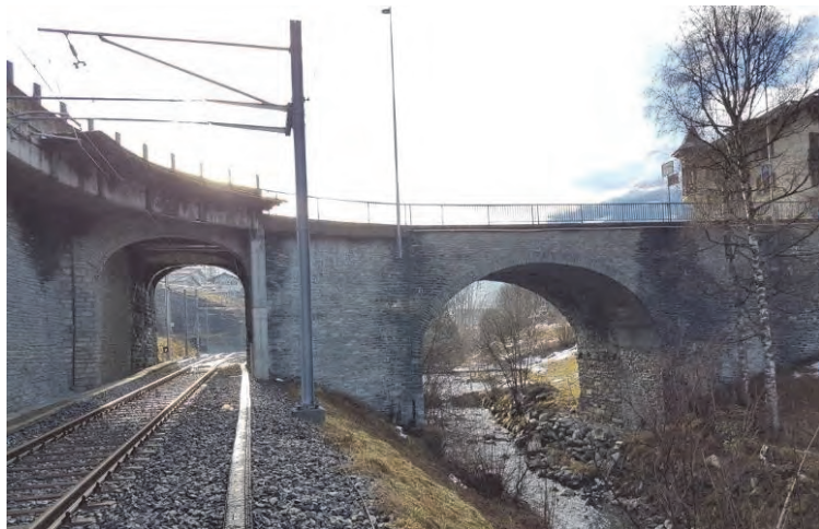
Fig. 1 : Pont sur la Dranse et la voie ferroviaire TMR au Châble
