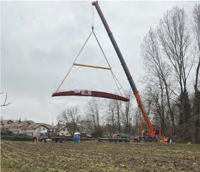
Fig. 10 : Vue de la pose du tablier avec un camion grue
