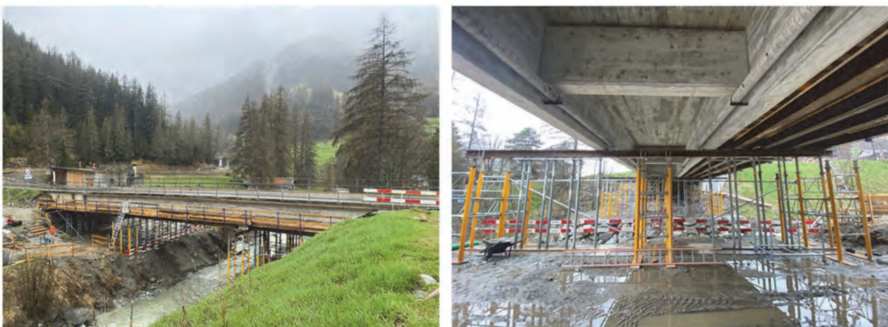
Fig. 10 : Installation de chantier et échafaudage pour soutenir le coffrage du porte-à-faux (Photos du 1 er mai 2023)
