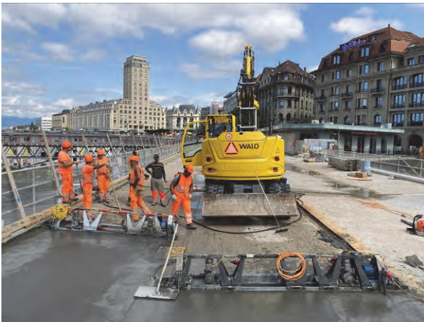
Fig. 7 : Pose de la couche d'étanchéité CFUP sur le tablier (photos INGPHI 2022)
