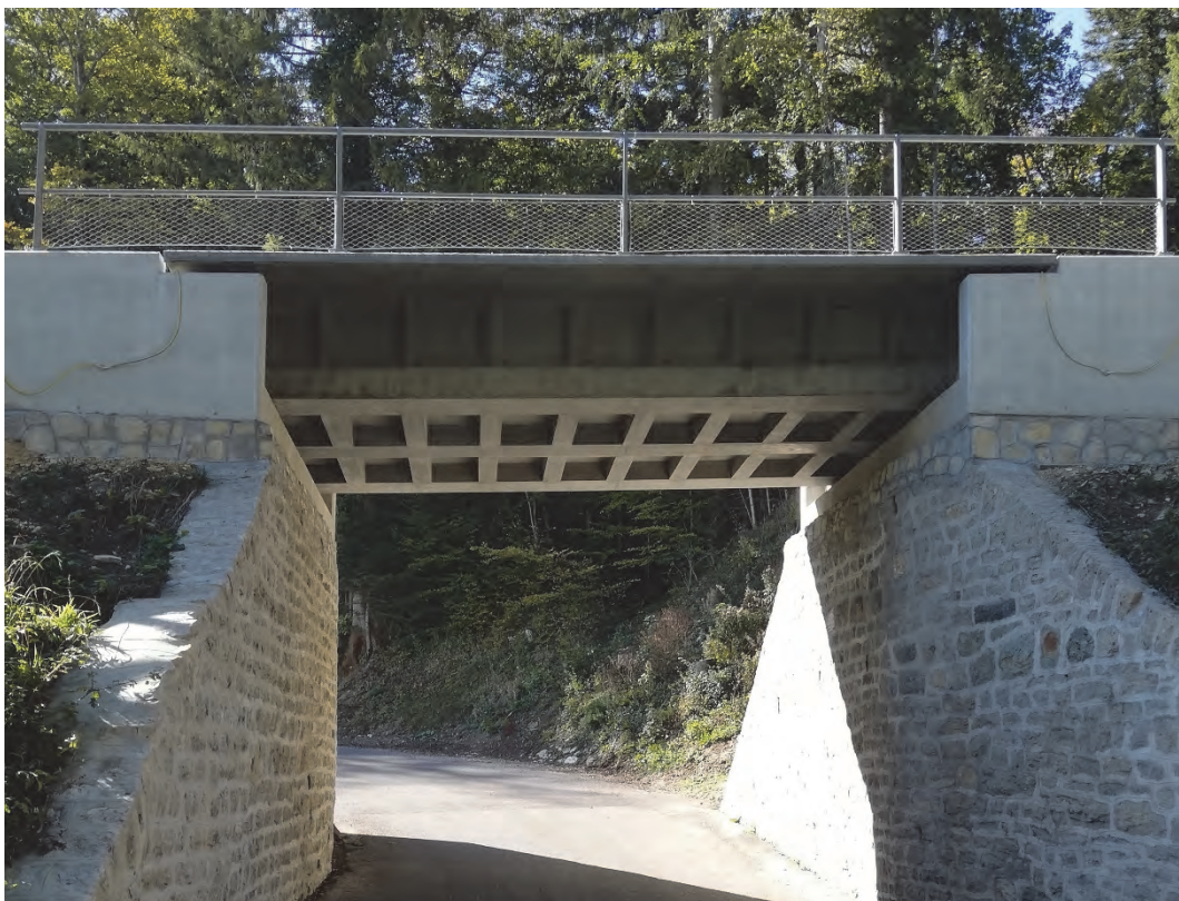
Fig. 1 : Le nouveau pont ferroviaire Aiguillon en CFUP armé
