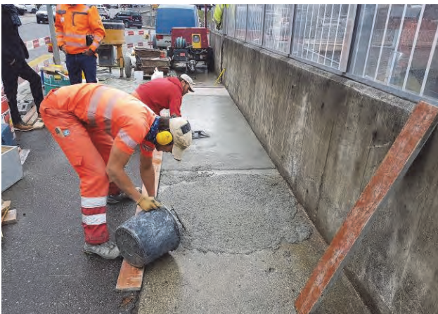
Fig. 9 : Planches d'essai réalisées avant le début du chantier
