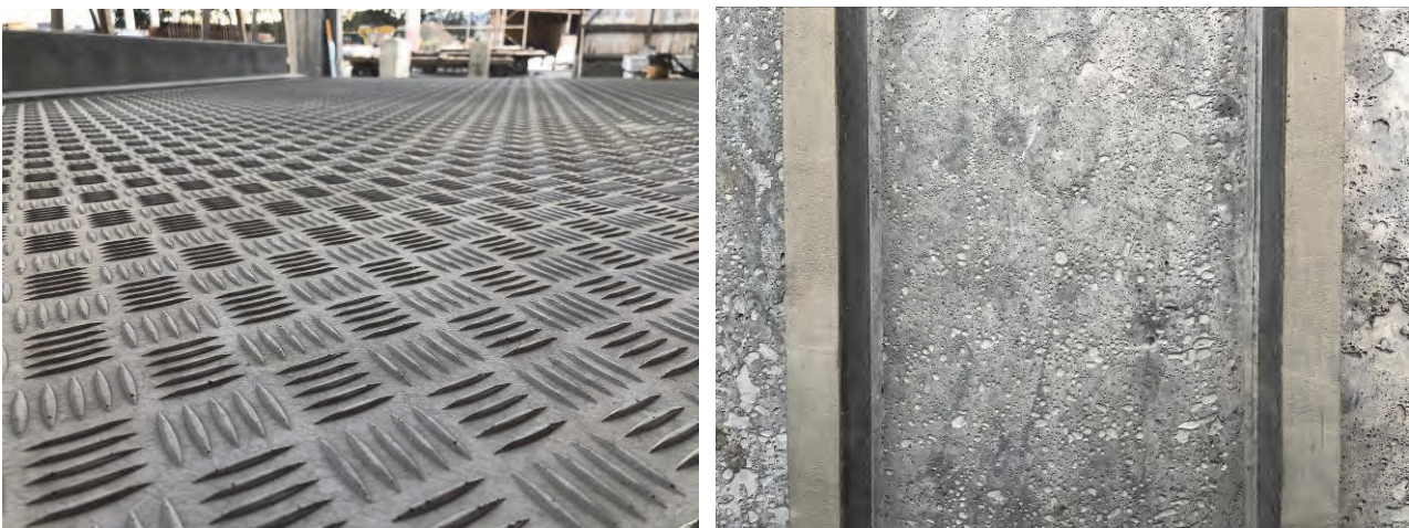
Abb. 12: a) Detail der Fahrbahnoberfläche, b) Ansicht der Brückenunterseite
