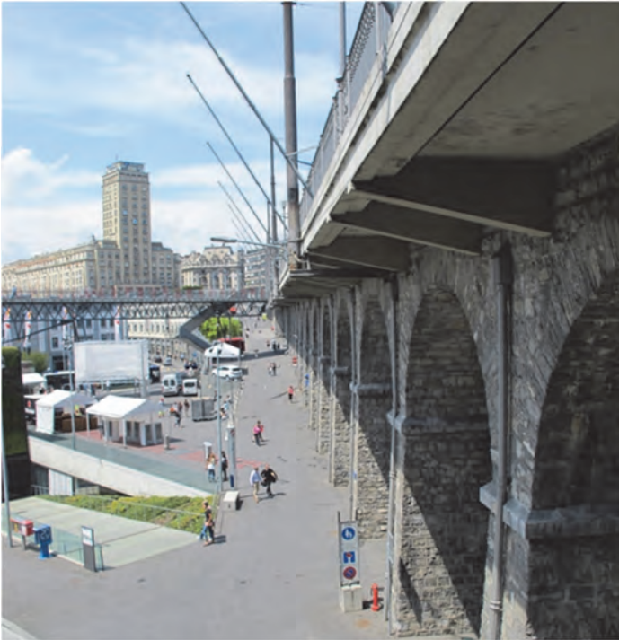
Fig. 3 : Élargissement du Grand-Pont de 1933 avec des encorbellements en béton (photo INGPHI 2017)
