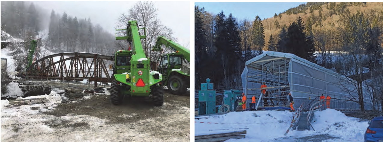
Abb. 6: a) Anheben des Stahltragwerks, b) Einhausung des angehobenen Tragwerks zur Instandsetzung der Stahlkonstruktion
