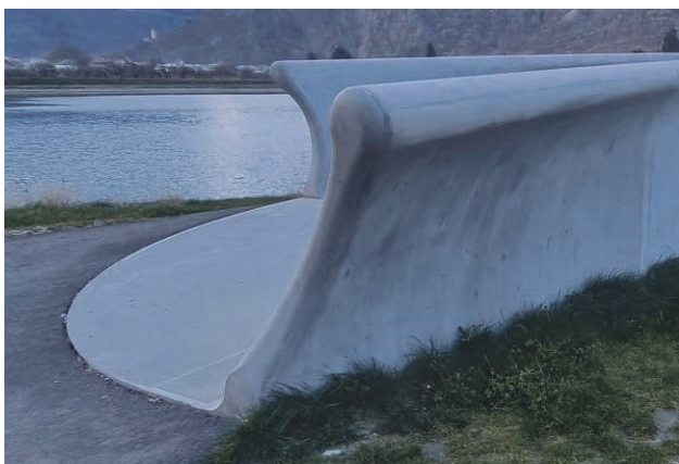
Fig. 4 : Détails architecturaux : extrémité des parapets et matrice anti-glissement
