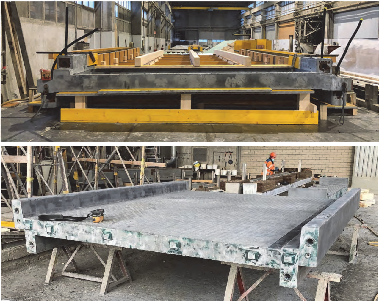
Abb. 8: a) Fertigung der auf dem Kopfhergestellten Fahrbahnelemente; Das Vorgängerelement dient zur Abschaltung, b) Ausgeschaltetes Fertigelement im Werk
