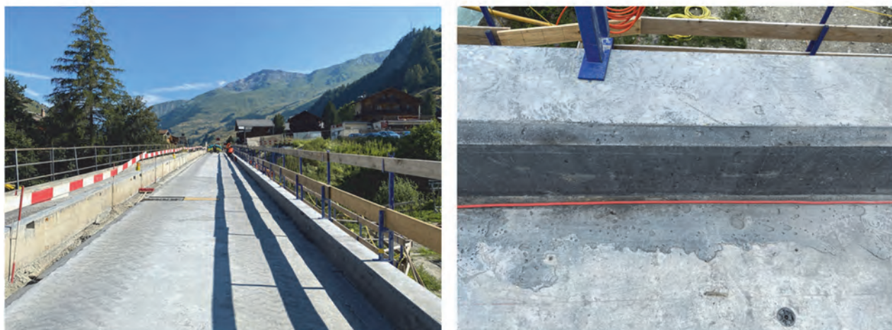
Fig. 12 : Résultat final de l'intervention au CFUP (Photos du 7 août 2023)
