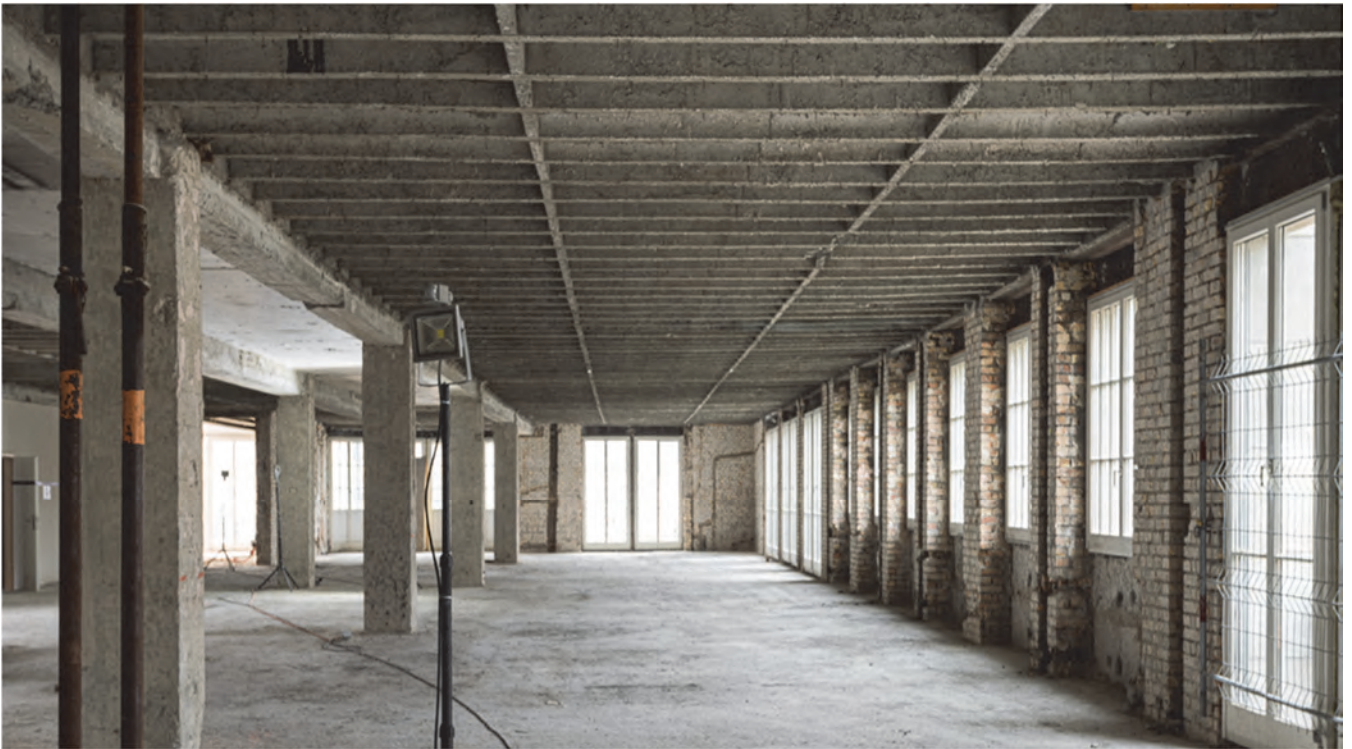
Abb. 1: Bestehende Rippendecke vor der Ertüchtigung
