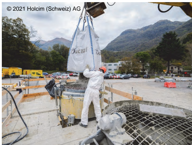
Fig. 11 : Production sur site du CFUP (produit Ductal® fourni en big-bags)
