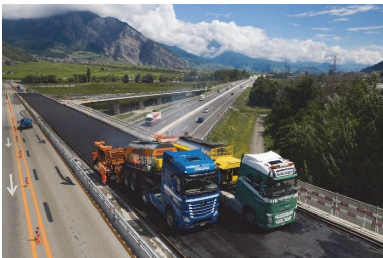
Fig. 11 Vue de la mise en place du revêtement ©Adrien Pilet
