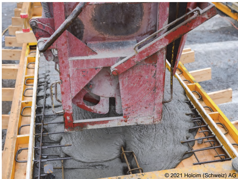
Fig. 12 : Coulage du CFUP et détail du ferrailage
