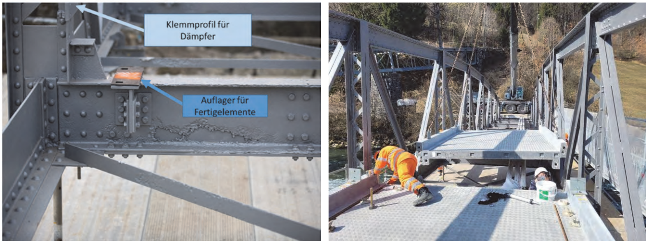
Abb. 9: a) Am Bestand angeschraubte Auflager für Fahrbahnelemente sowie Lage der angeordneten Klemmprofile für die Dämpferelemente, b) Montage der Fertigelemente
