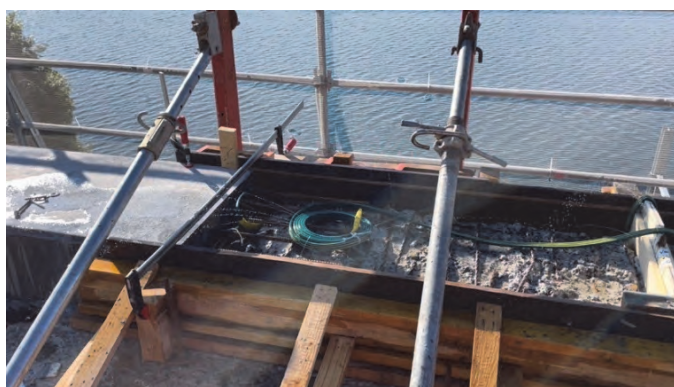
Fig. 10 : Bordure de l'ouvrage NB 74 : Préparation du support et joint de reprise
