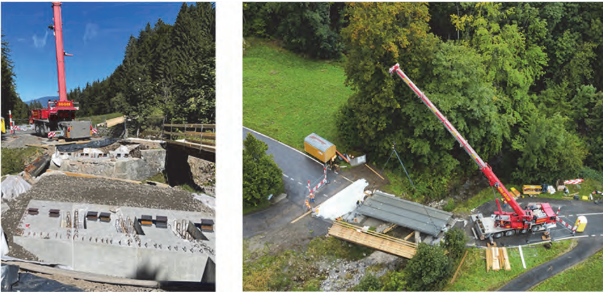
Fig. 10 : Pose à la grue des fondations et du tablier
