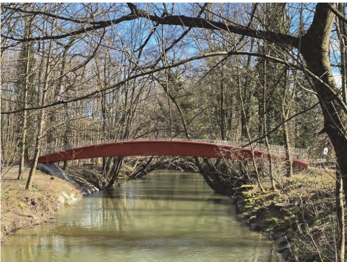
Fig. 11 : Vue de face de la passerelle
