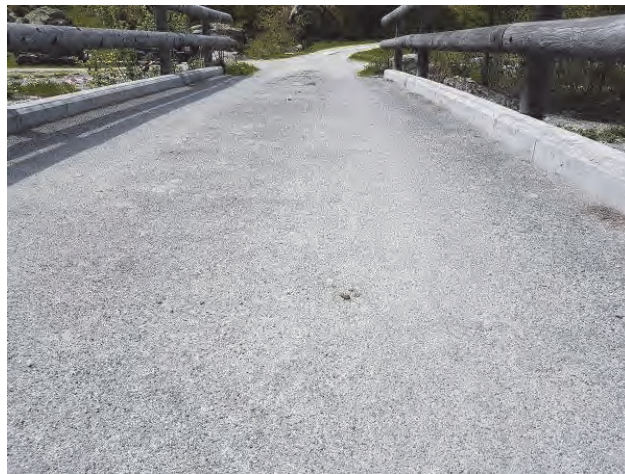
Fig. 16 : Réalisation du revêtement par saupoudrage des gravillons et aspect après 5 ans
