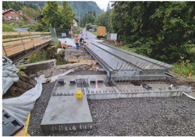
Fig. 9 : Détail pour le clavage des éléments du tablier (à gauche) et pose des fondations côté St-Gingolph et de deux tronçons de tablier (à droite)
