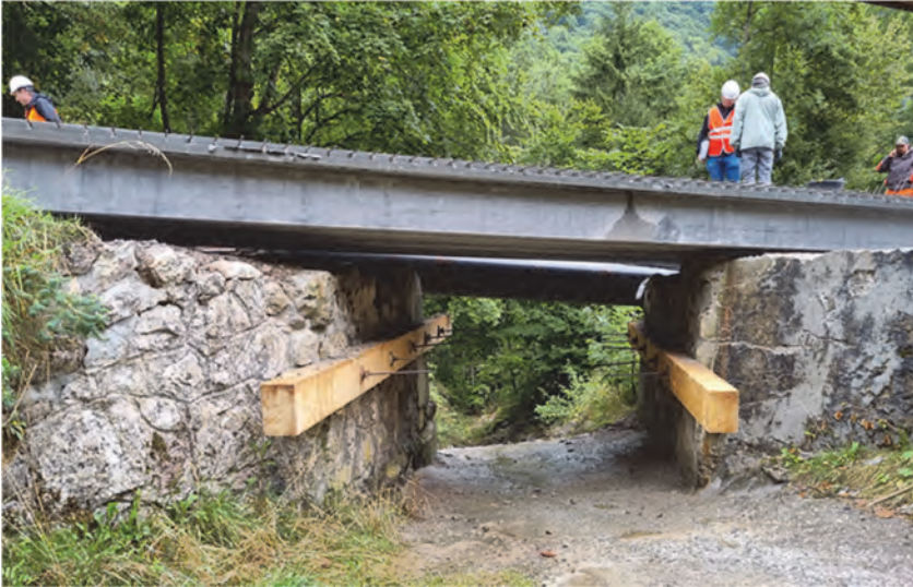
Fig. 8 : Vue sur le tablier du nouveau Pont de Clarive
