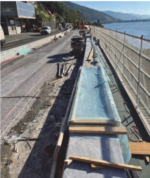
Fig. 12 : Bordure du pont NB 74 : châssis de cure à gauche ; vue de la bordure depuis l'extérieur après cure, image à droite
