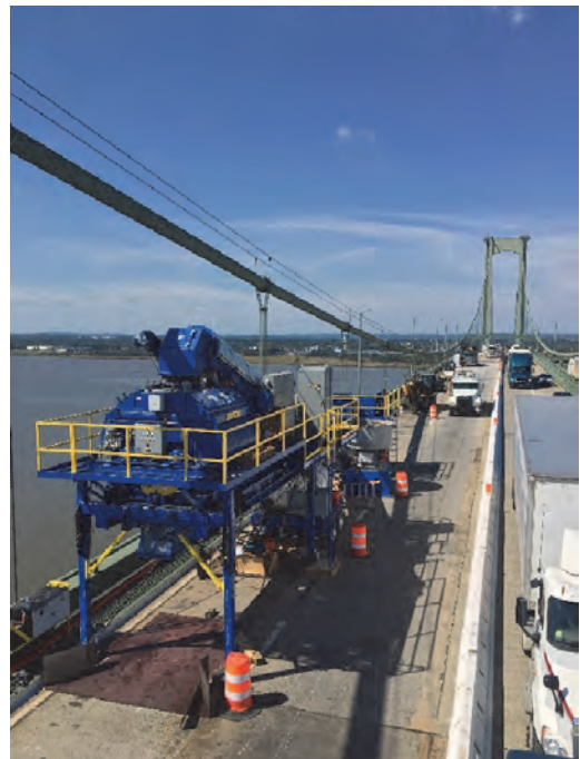
Abb. 8: Mischanlage auf der Brücke
