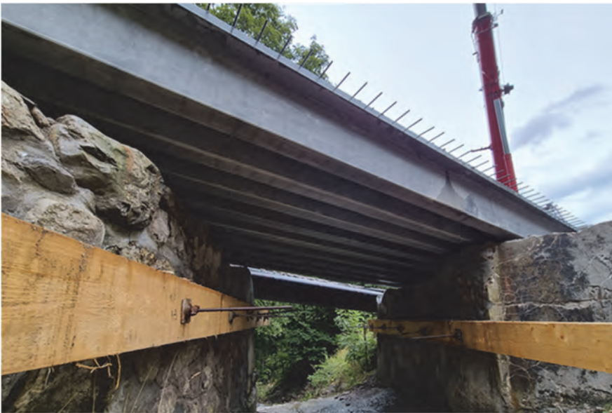
Fig. 3 : Vue de la sous-face du tablier du Pont de Clarive avec ses 12 sommiers longitudinaux
