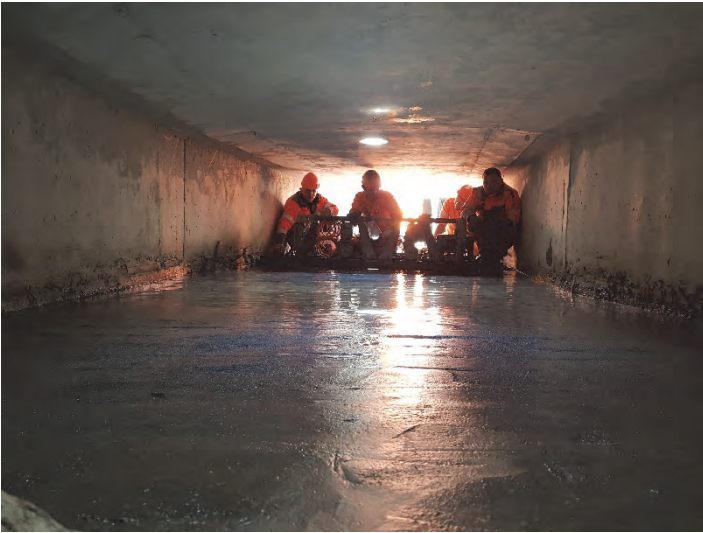
Fig. 12 : Vue à l'intérieur du caisson de la pose du CFUP
