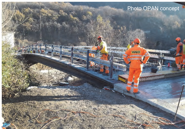
Fig. 15 : Réalisation de la surcouche et des dalles de transition, servant de couche de roulement définitive
