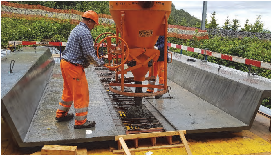
Fig. 8 : Clavetage de deux éléments préfabriqués du tablier par le CFUP coulé sur place
