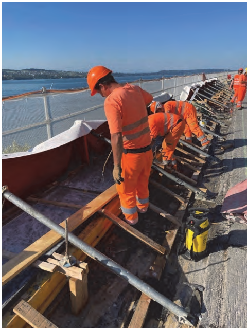
Fig. 11 : Exécution de la bordure : application du produit de cure à gauche ; nattes thermique à droite
