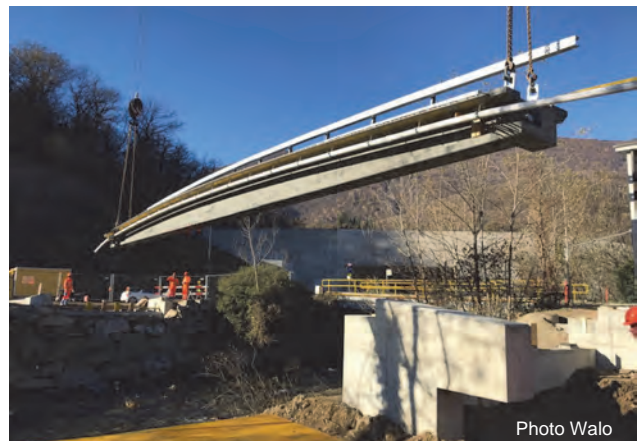
Fig. 14 : Levage et mise en place d'une poutre de bord. Celle-ci est munie de sa bordure, du dispositif de retenue et de toutes les conduites de tiers
