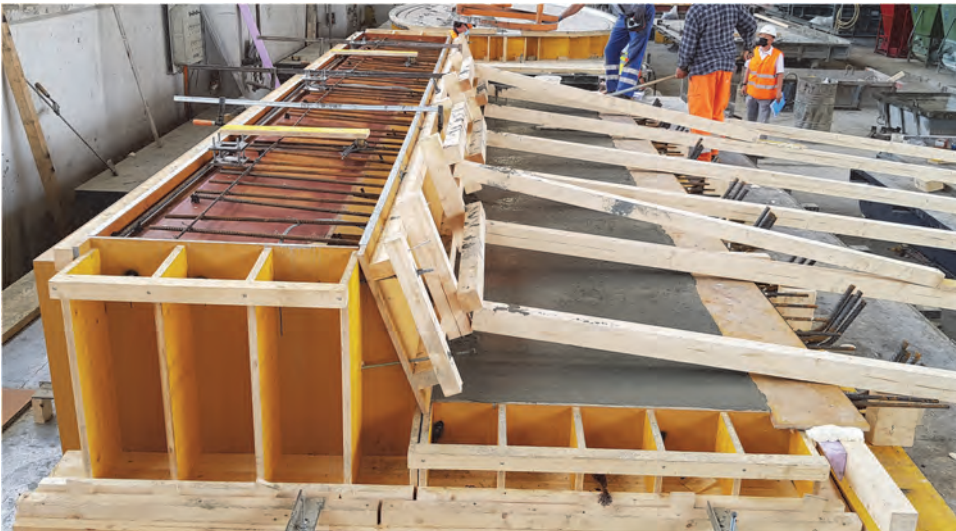
Fig. 7 : Fabrication d'un élément du tablier en CFUP en usine
