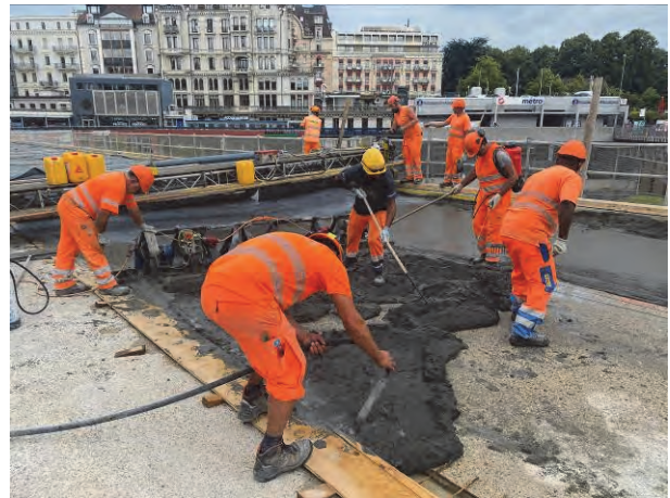
Fig. 7 : Pose de la couche d'étanchéité CFUP sur le tablier (photos INGPHI 2022)
