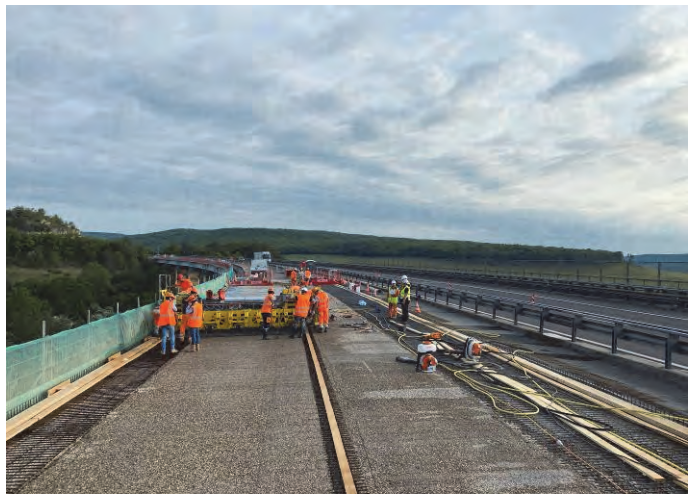
Abb. 2: Pont d'Ouche - Viadukt
