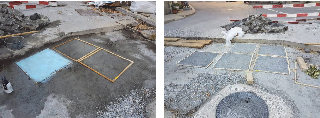
Fig. 10 : Planches d'essai réalisées par l'entreprise adjudicatrice au début du chantier
