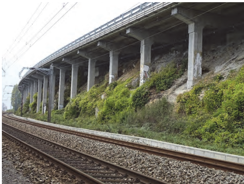
Fig. 8 : Pont NB 74 – Lehnkonstruktion Alfermée-Funtelen
