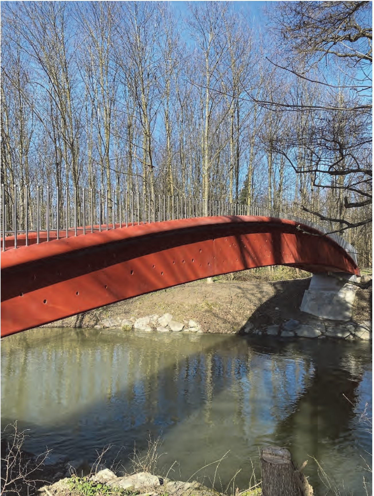
Fig. 12 : Vue de la passerelle en enfilade
