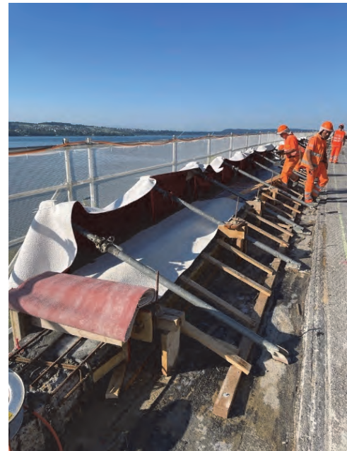
Fig. 11 : Exécution de la bordure : application du produit de cure à gauche ; nattes thermique à droite
