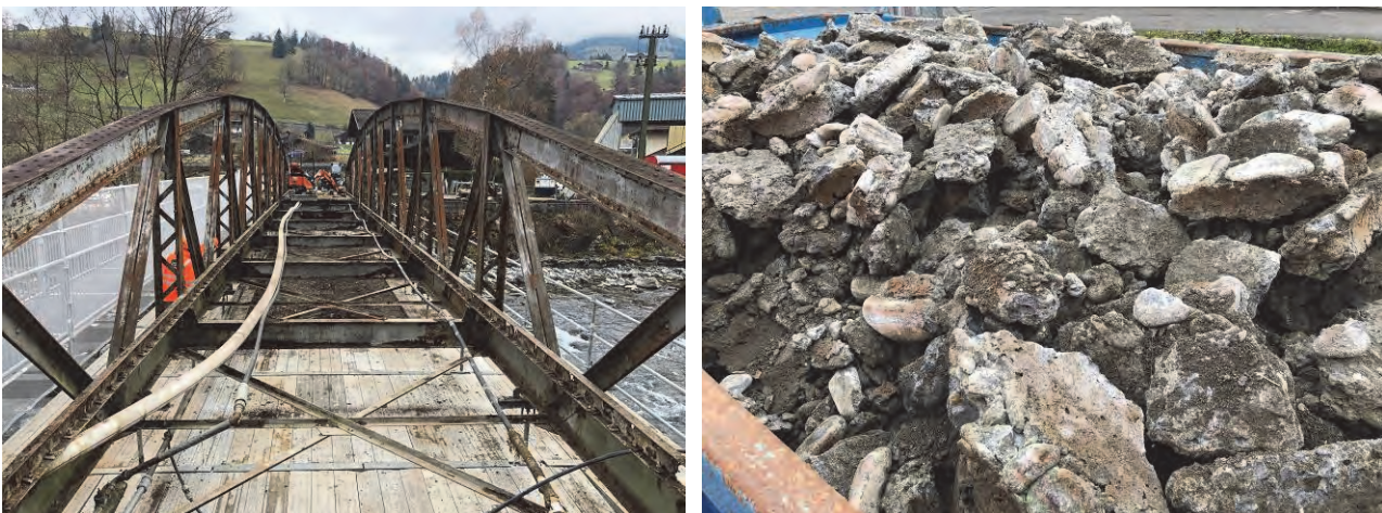
Abb. 5: a) Freigelegtes Stahltragwerk, b) Massiges Rückbaumaterial in der Sammelmulde
