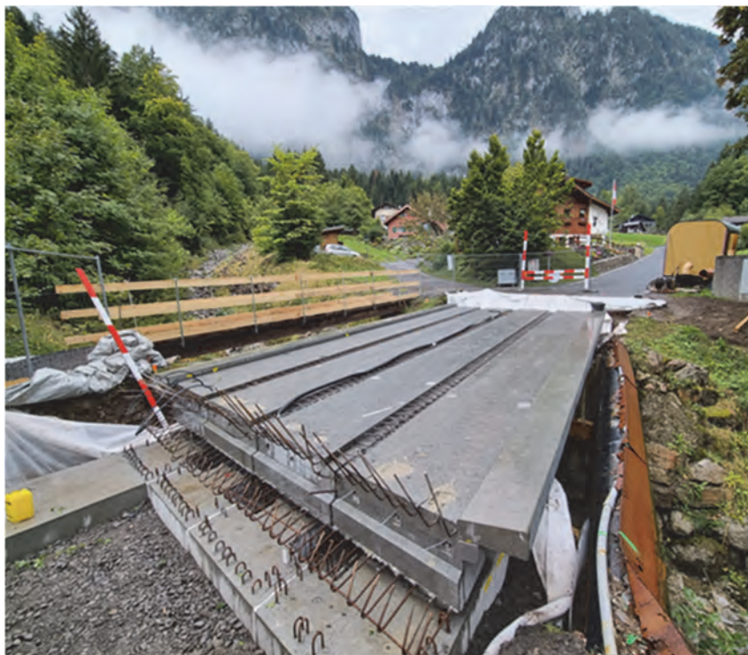
Fig. 2 : Vue du nouveau Pont de Clarive (Quatre éléments distincts du tablier ainsi que la fondation côté St-Gingolph)
