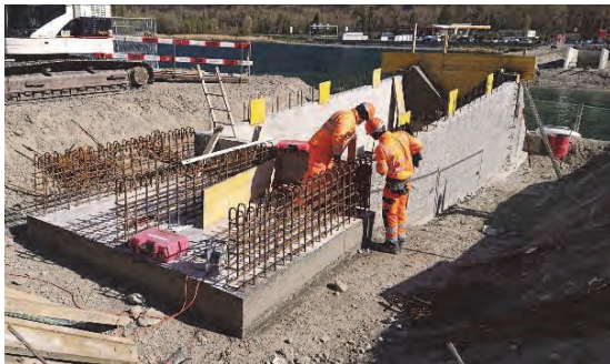
Fig. 6 : Travaux et élévation de la culée côté Western City
