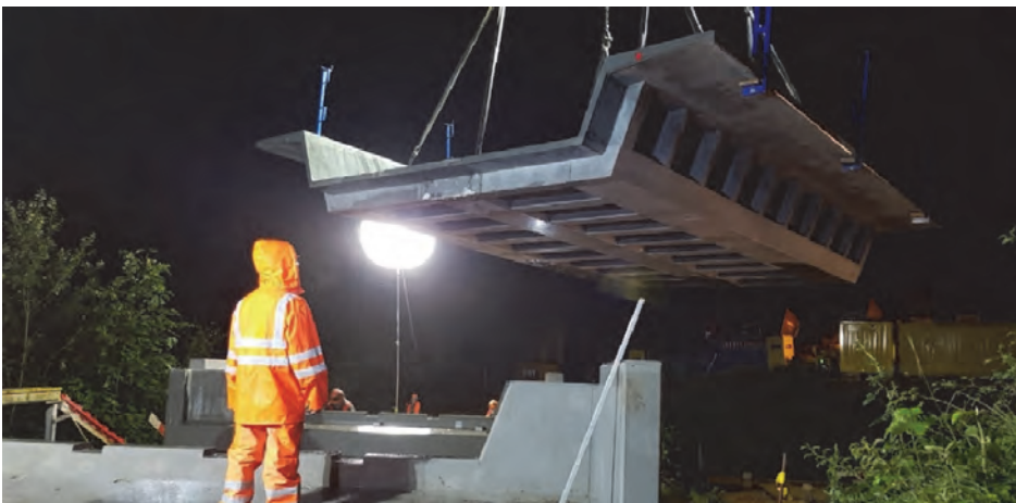
Fig. 9 : Pose du nouveau tablier pendant travaux de nuit
