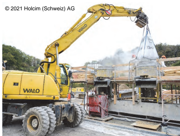
Fig. 11 : Production sur site du CFUP (produit Ductal® fourni en big-bags)
