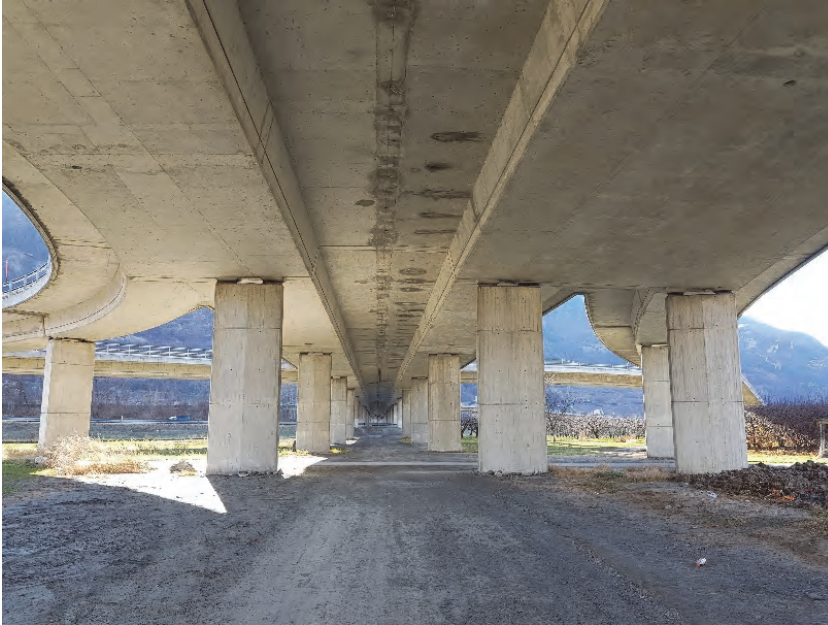
Fig. 4 : Vue du viaduc principal à proximité de la jonction
