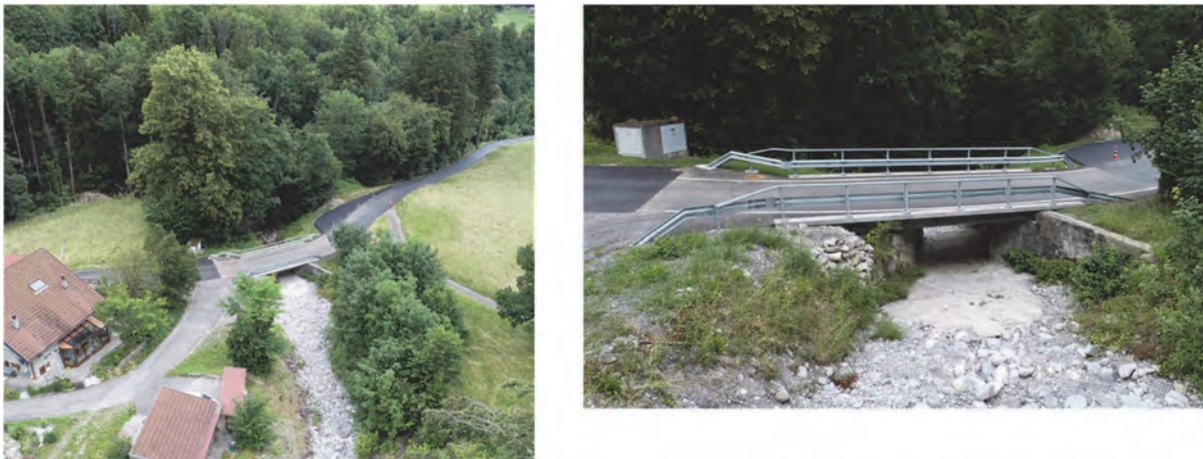
Fig. 11 : Photos du nouveau Pont de Clarive terminé
