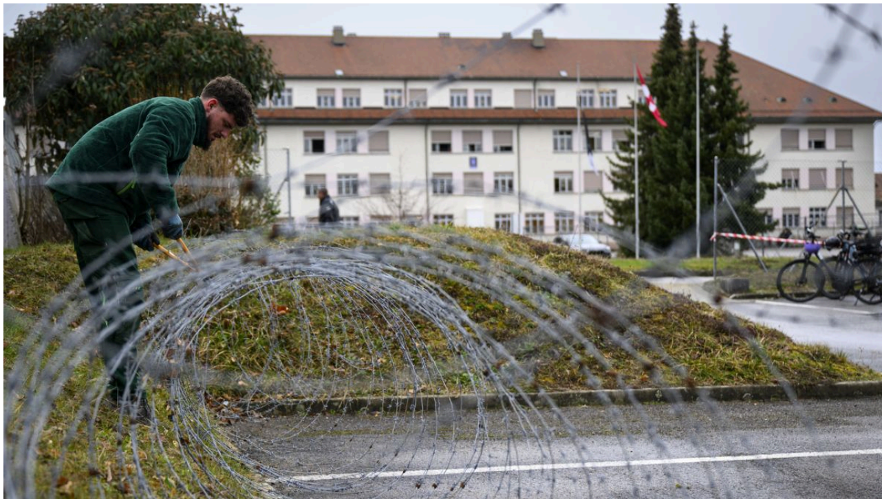
Une buvette gastronomique ainsi que des mobile-homes seront installés sur l'ancien site militaire fribourgeois par des artisans locaux et des étudiants de la Haute Ecole d'Architecture de Fribourg. © KEYSTONE
