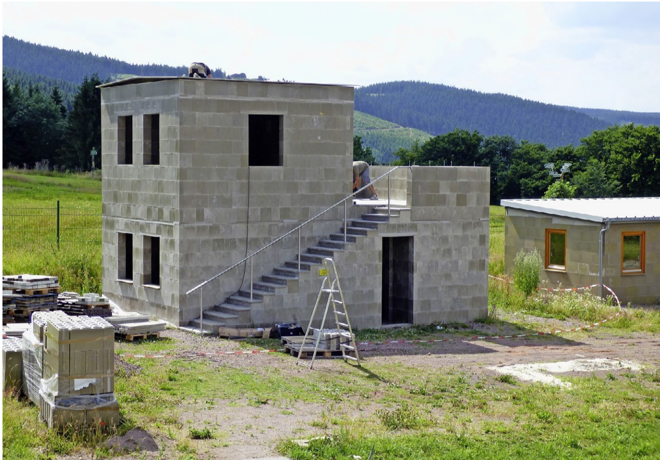
Zweistöckiges Musterhaus (Mitte) und Bungalow (rechts), gebaut mit «Legosteinen» aus Polymerbeton. Fotos: PD
